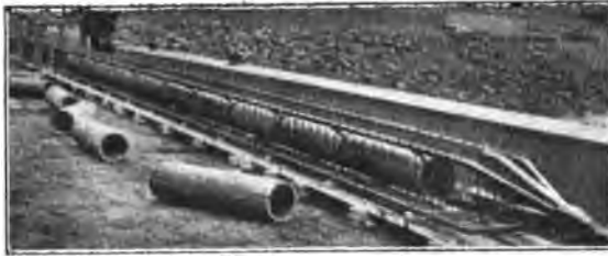
Fig. 189. — Ossature de pieu Mouchel.
