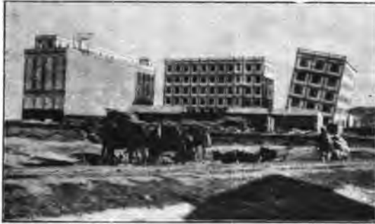
Fig. 216. — Entrepôts à blé à Tunis à la suite d'affaissement des fondations.
