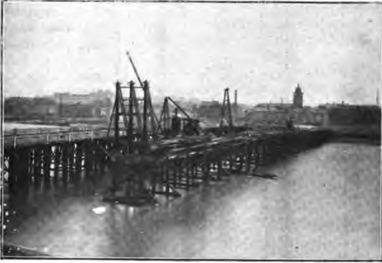
Fig. 270. — Construction du pont provisoire en bois.
