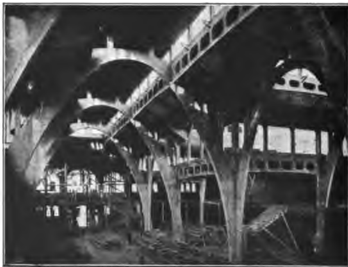
Fig. 248. — Charpente du marché couvert de Breslau.
