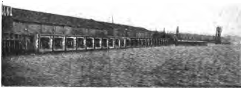
Fig. 339. — Mur de quai à Dundee.
