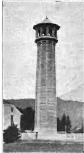
Fig. 397. — Tour à poussière construite en claveaux Monnoyer.
