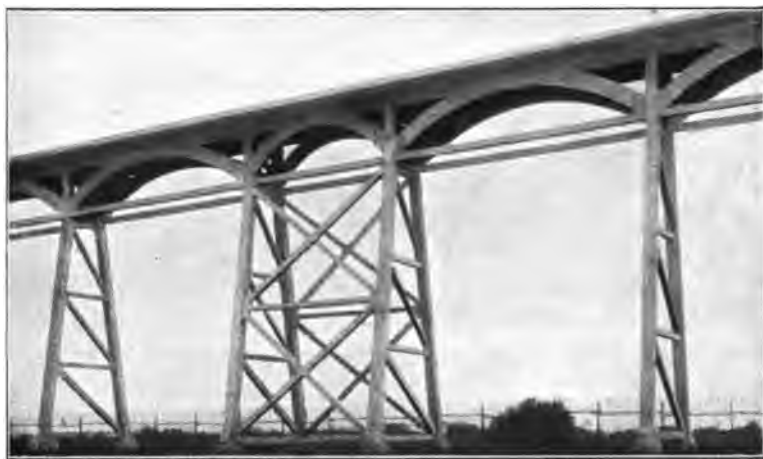
Fig. 272. — Vue d'une des travées fixes.
