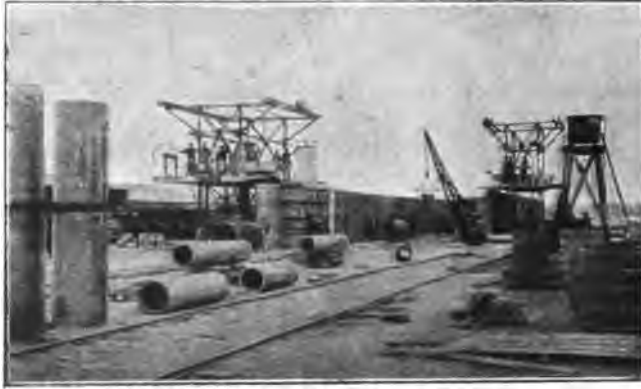
Fig. 384. — Chantier de construction de tuyaux à Achères.
