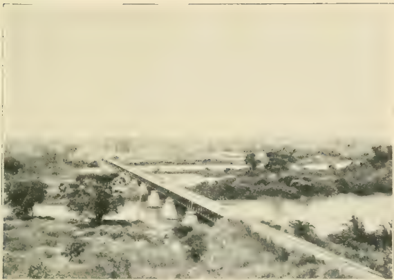
CHEMIN DE FER DE KAYES AU NIGER. LE PONT SUR LE BAKOY (HAUT-SÉNÉGAL-NIGER).
