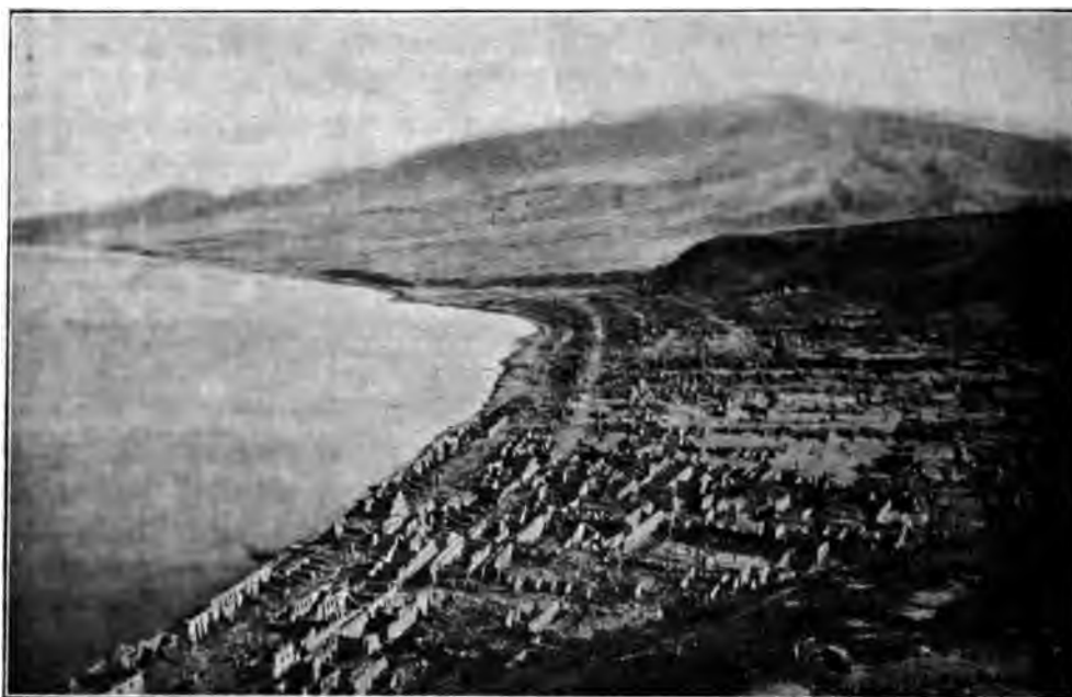
FIG. 17. — L'ORIENTATION DE LA DESTRUCTION DANS LES RUINES DE SAINT-PIERRE.
