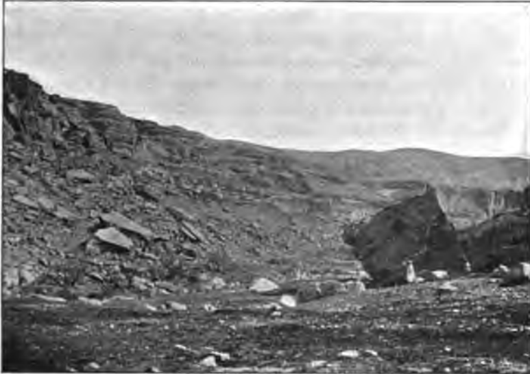
FIG. 21. — EXEMPLE DE DÉLITEMENT DE LA ROCHE SUR LES BORDS DE LA GORGE DE L' oued CHÉRIA EN AVAL D'OUËM-EL-KRALED.
