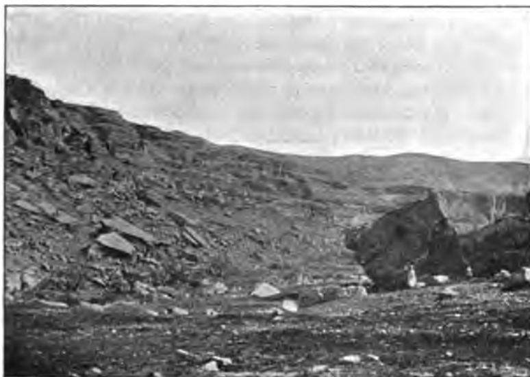
FIG. 21. — EXEMPLE DE DÉLITEMENT DE LA ROCHE SUR LES BORDS DE LA GORGE DE L' oued CHÉRIA EN AVAL D'OU-M-EL-KRALED.
