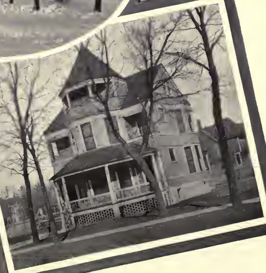
No. 2—201 South Waiola Avenue
