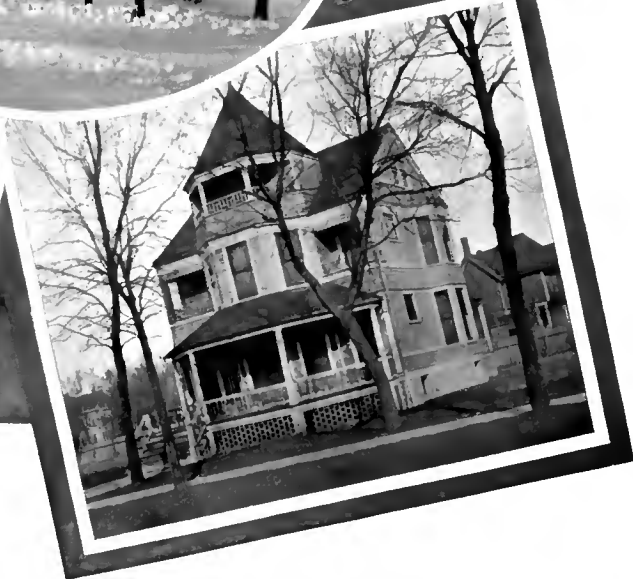
No. 2—201 South Waiola Avenue
