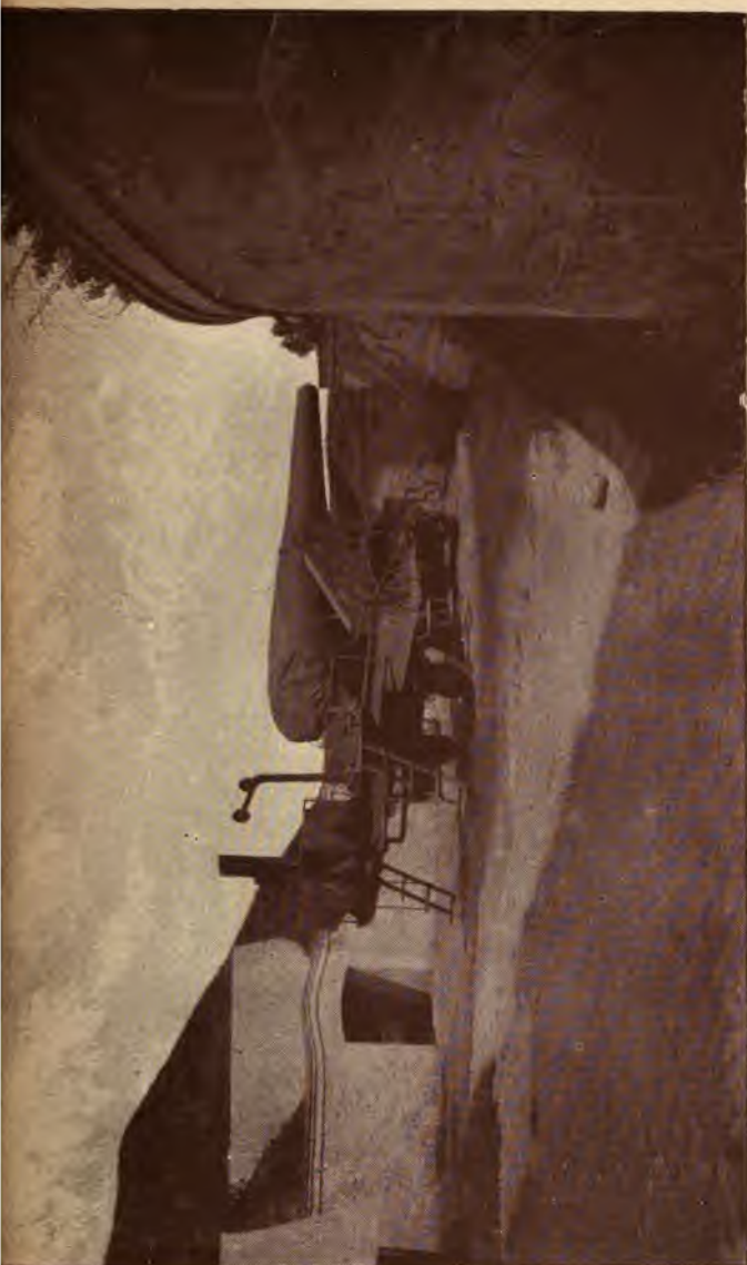
BATERÍA DE SANTA CLARA Un cañón de 30'5 cm. (Ordóñez) entre dos traveses.
