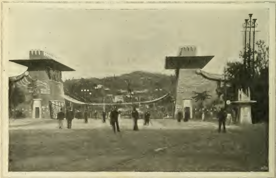
INGRESSO PRINCIPALE DALL'ESTERNO.
