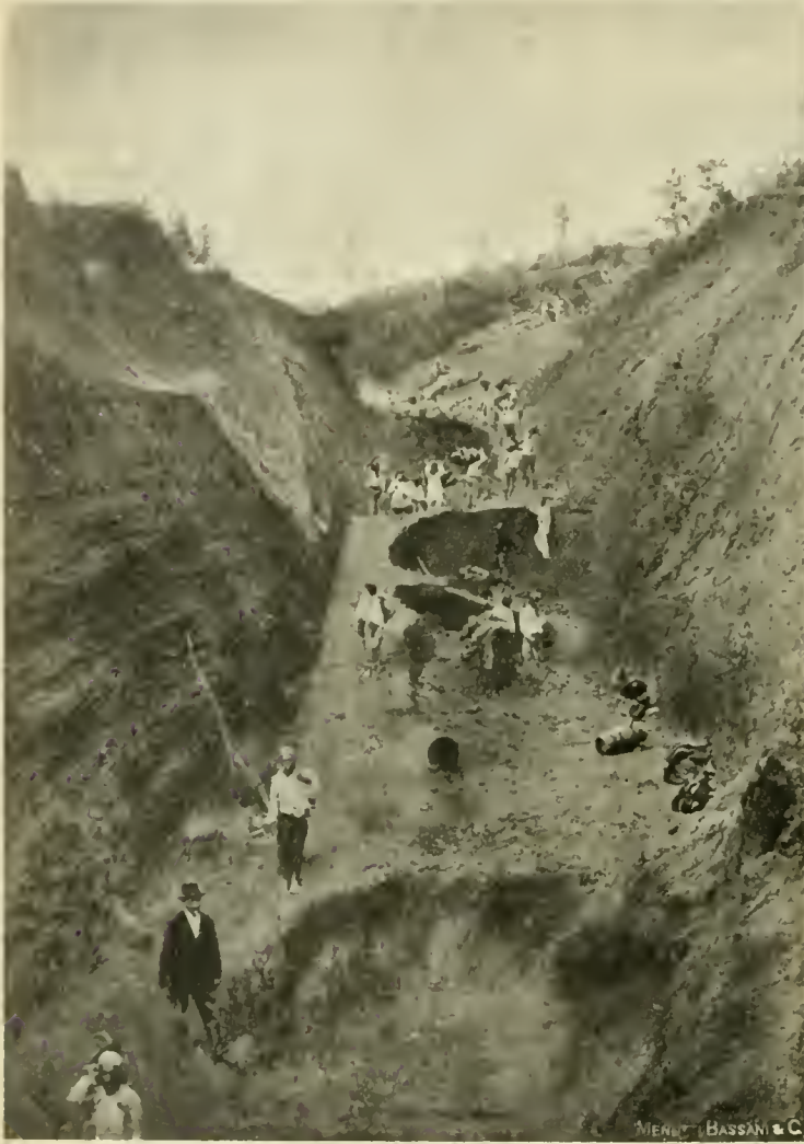
SCAVI PER LA NUOVA FERROVIA ELETTRICA.
