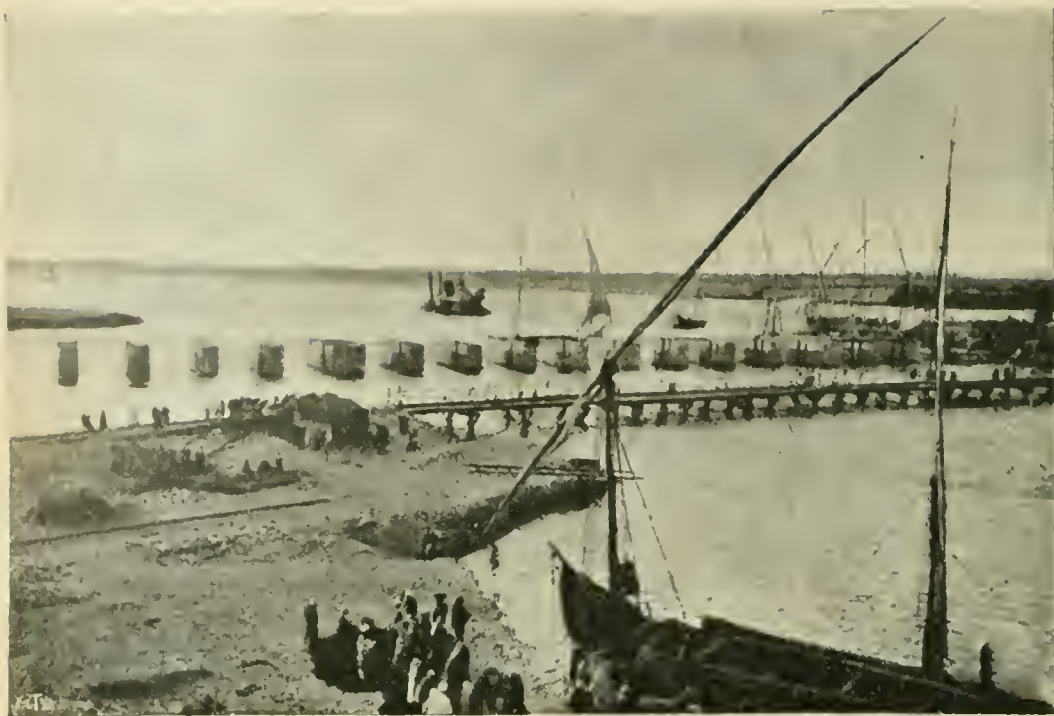
Primi lavori della diga ad Assuan.
