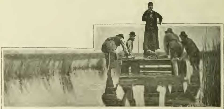
Un ispettore su una ferrovia allagata.
