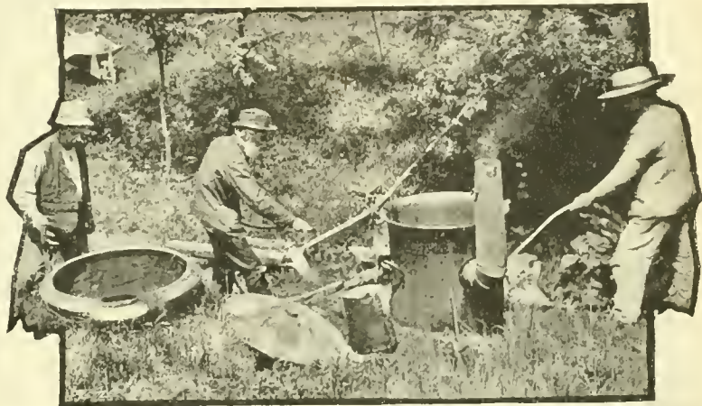
LA PREPARAZIONE DELLA VERNICE.
