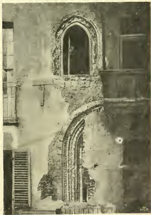
Archi di finestre antiche nella casa del Missaglia.
