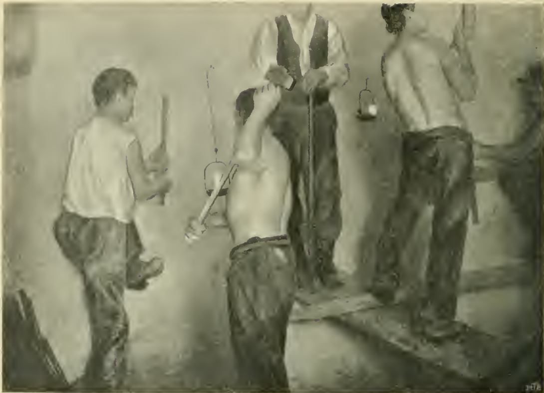
I « fornelli » nella vólta. — (Fotografia della « Lettura » ottenuta al magnesio .
