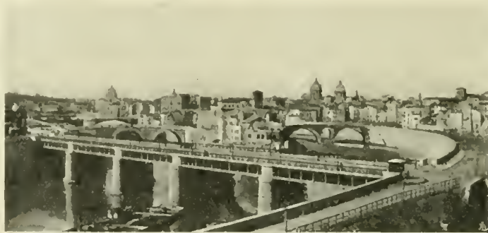
Ponte Sisto Ponte Garibaldi Ponte Cestio Ponte Palatino Ponte Fabricio
