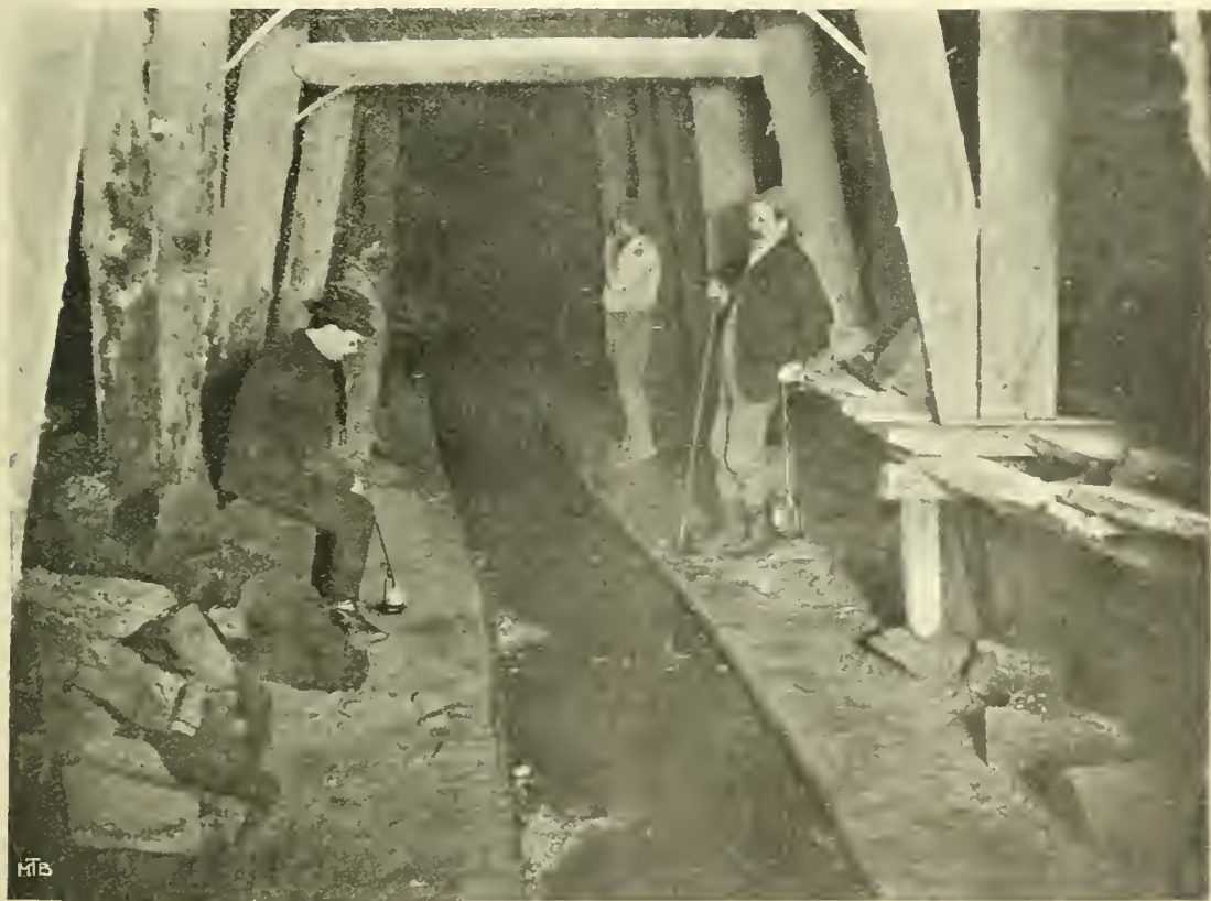
A Iselle. — A 3000 metri nel tunnel in attesa di un treno. — Fot. della « Lettura » ottenuta al magnesio.
