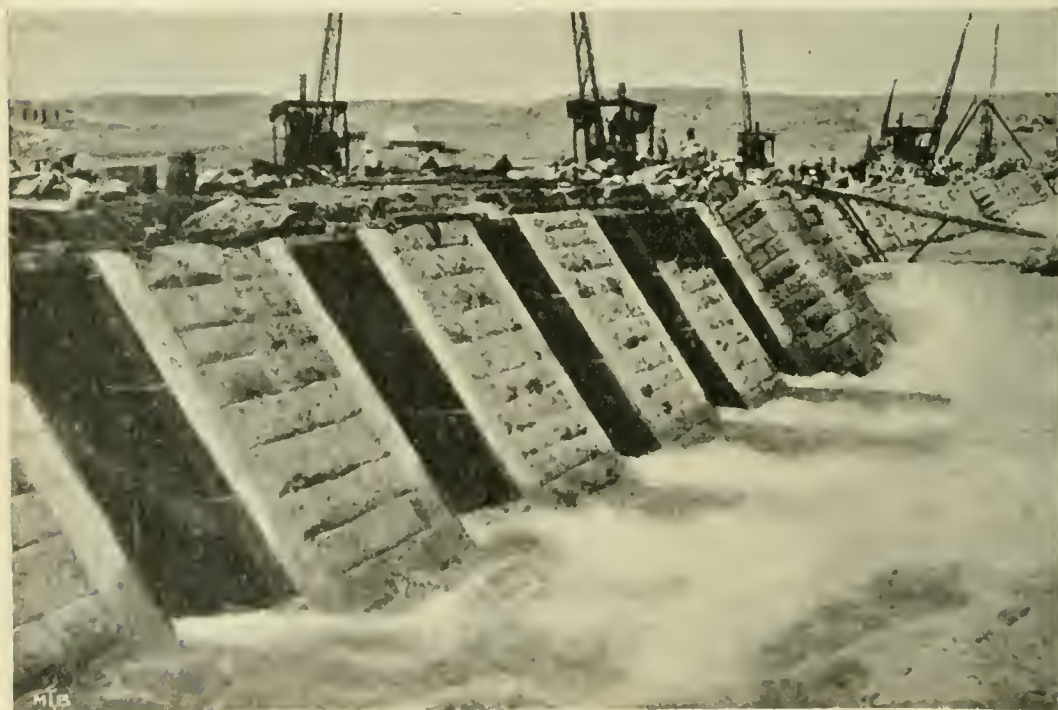
Una facciata della diga.
