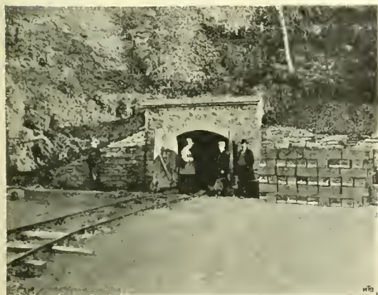
A Briga. — Il tunnel di direzione.
