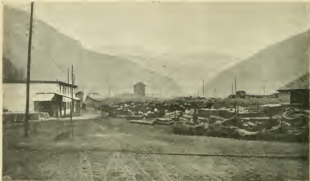
A Briga. - La futura stazione dell'accesso nord del tunnel. — (Fot. della « Lettura »).
