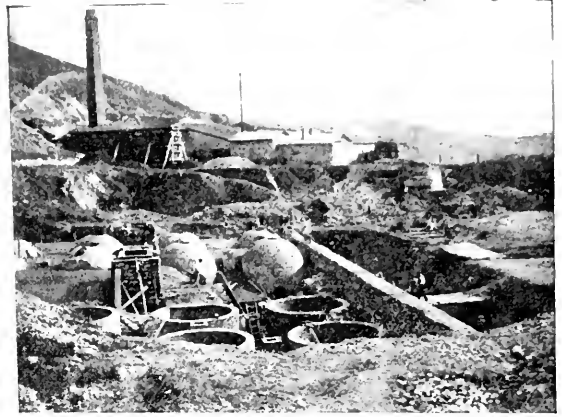
(Fig. 12). FORNI GILL IN COSTRUZIONE.
