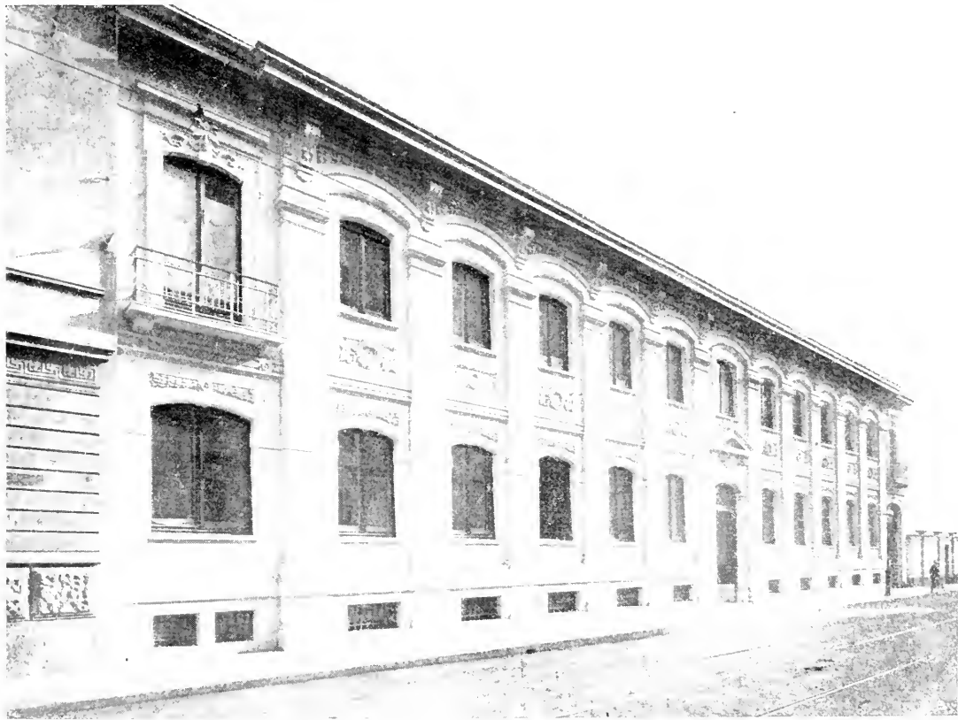
Fig. 1. — FACCIATA VERSO VIA SOLFERINO.
