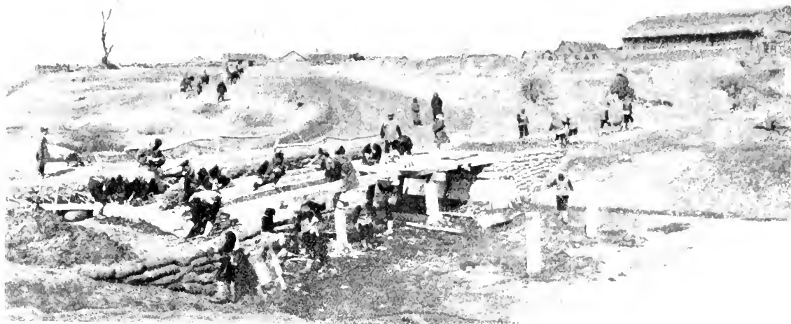
Febbrile costruzione d'un ponte sullo Sha-ho gelato, durante la battaglia (3 marzo).
