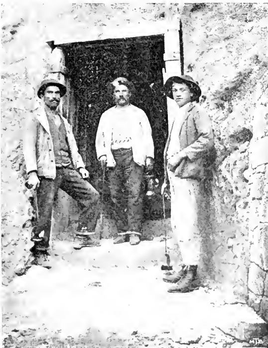
(Fig. 4). OPERAI ALL'INGRESSO DI UNA DISCENDERIA.
