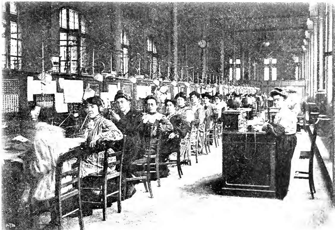
NELLA CENTRALE TELEFONICA.
