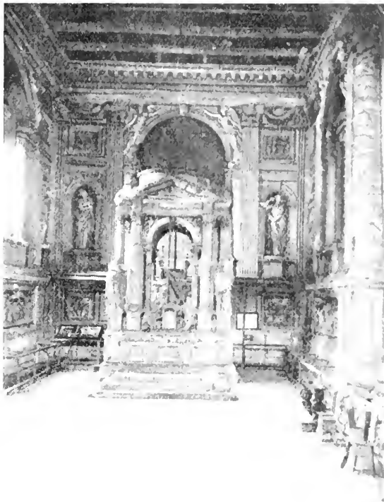
CHIESA DEI SS. GIOVANNI E PAOLO. La Cappella del Rosario come fu ridotta dall'incendio del 1597.
