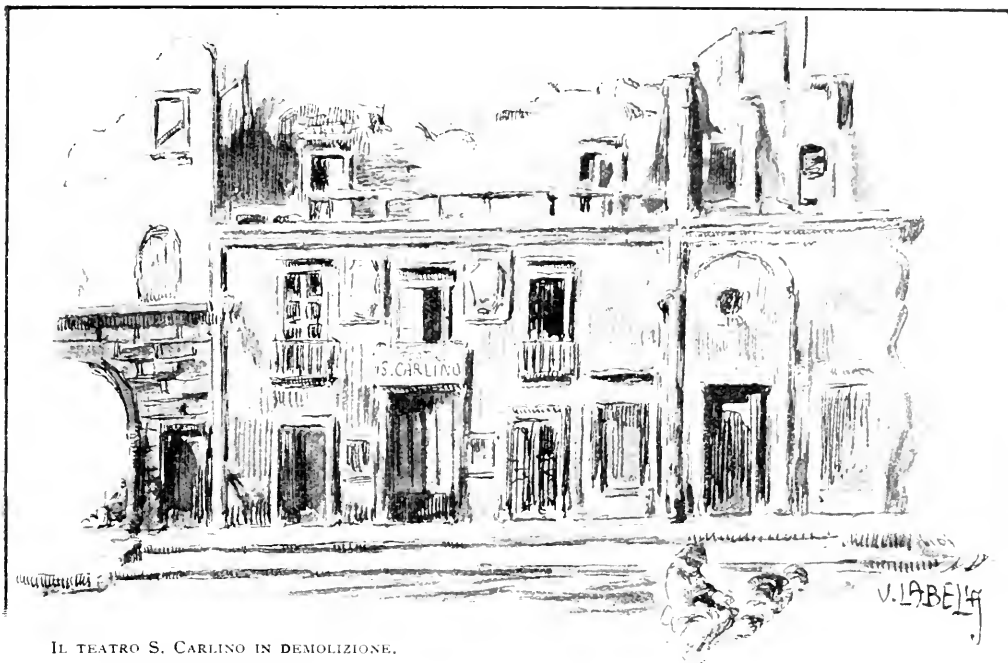
IL TEATRO S. CARLINO IN DEMOLIZIONE.
