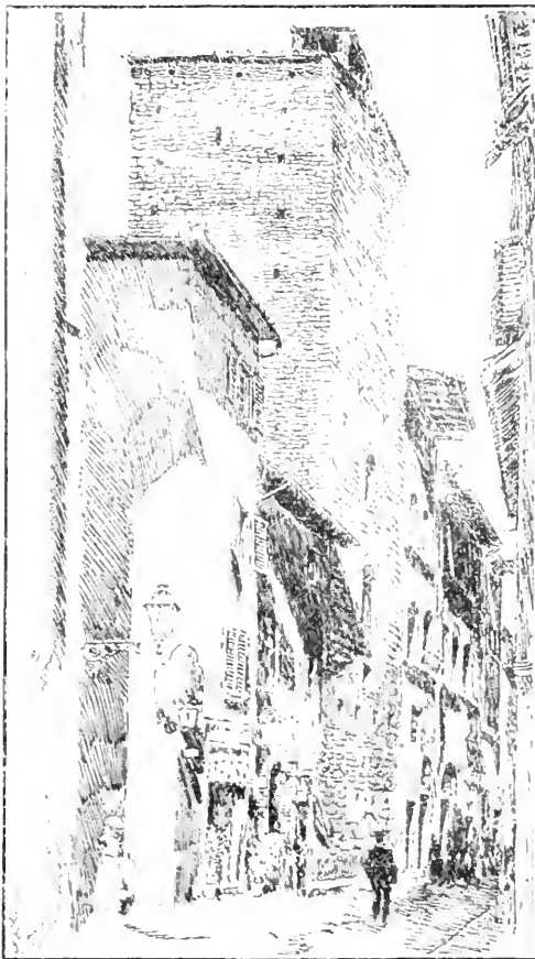
TORRE DE' VISDOMINI (esistente). Fot. Alinari.
