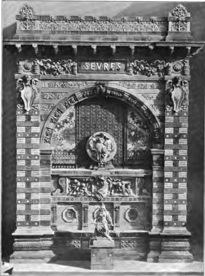
Travée d'un palais d'exposition des produits de Sèvres. — Grès cérame. 1900. Ch. Risler, architecte. Coutan, sculpteur. (Square Saint-Germain-des-Prés.)
