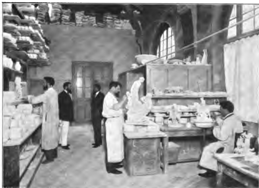
Grand atelier de fabrication. — Les mouleurs-répareurs.
