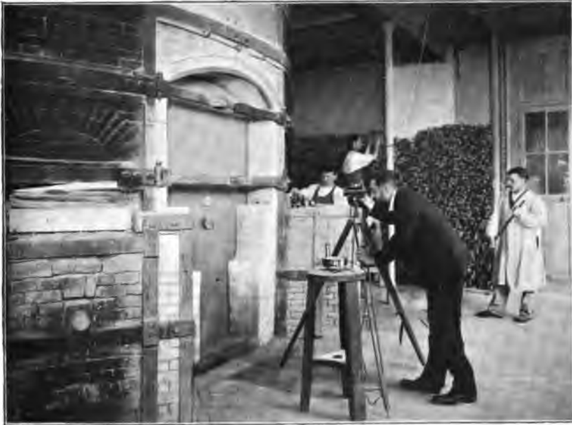
Évaluation de la température intérieure d'un four au moyen du pyromètre Fery.
