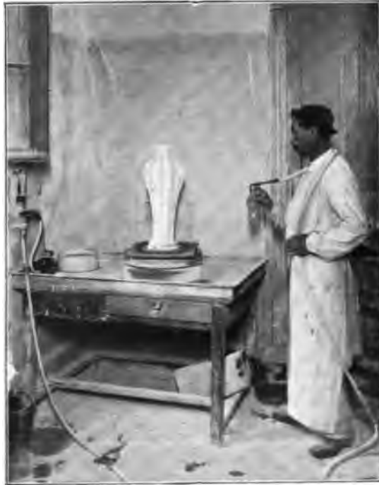
Atelier de mise en couverte par le procédé de l'insufflation.
