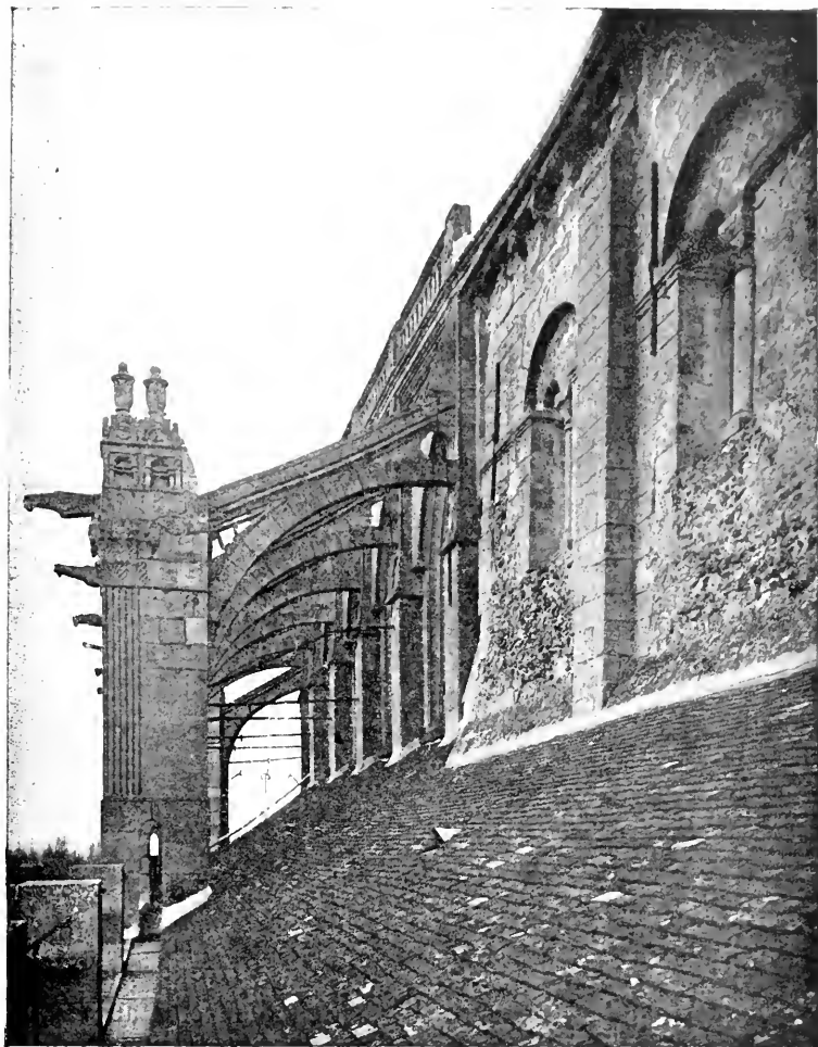
ÉGLISE DE MONTFORT-L'AMAURY (SUD-OUEST)
