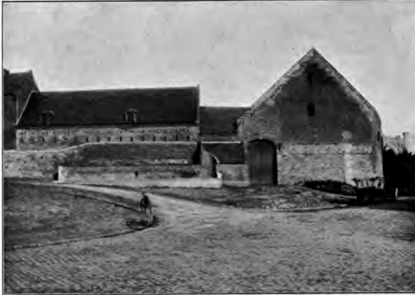
UNE GRANDE FERME A MONCHY-LE-PREUX (ARRONDISSEMENT D'ARRAS) Le bas des murs est en grès d'Artois.
