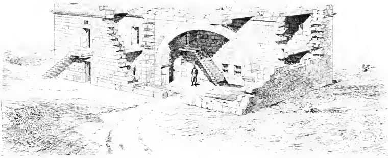
323. — Maison toute en pierres du Hauran. (D'après M. de Vogüé, Arch. de la Syrie centr. )
