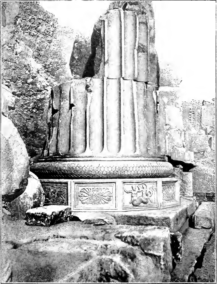
235. — Colonne à base dodécagonale du Didymeion. (D'après Pontremoli et Haussoullier, Didymos .)
