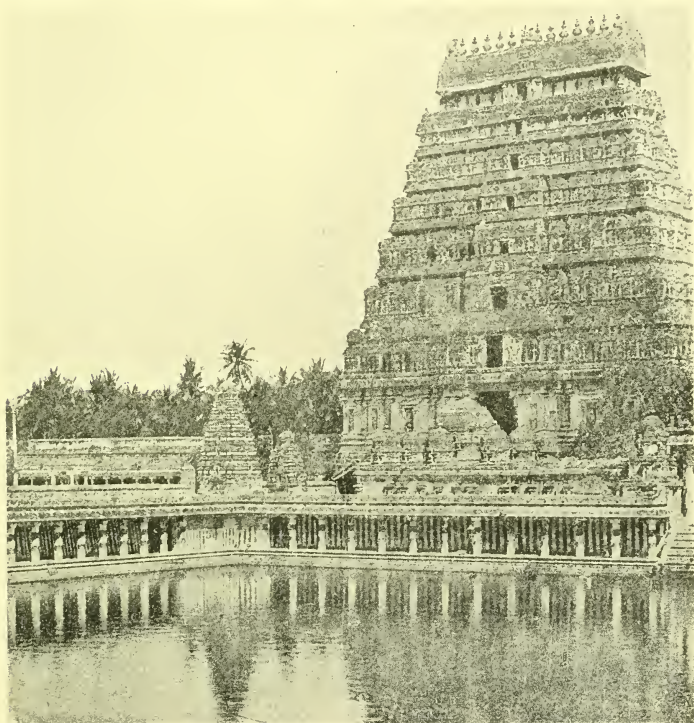
194 — Gopuram et étang sacré de la pagode de Chillambaram. (D'après G. Le Bon, op. cit. )
