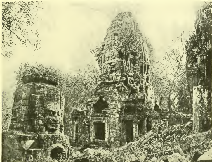
263. — Tourelle et tours du troisième étage du Bayon, à Angkor. (D'après Fournereau, Les ruines d'Angkor. )
