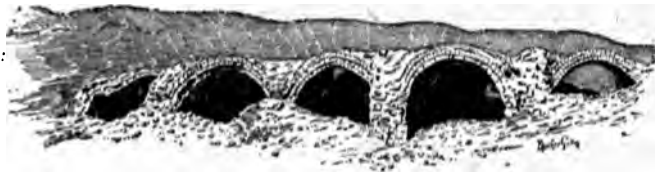
FIG. 44. — LES GRENIERS DU RAMESSÉUM AVANT LE DÉBLAYEMENT
