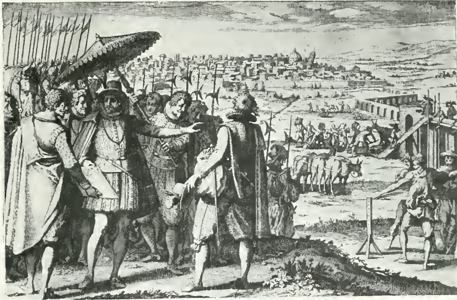
FERDINAND I er , GRAND-DUC DE TOSCANE, FAISANT CONSTRUIRE L'AQUEDUC DE PISE.
