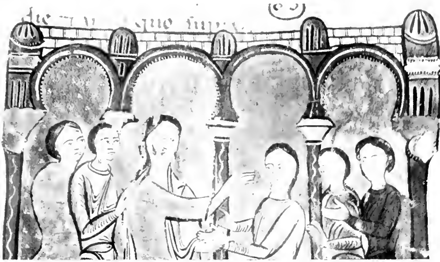
Fig. 170. Construcció ab archs de ferradura. (Del Liber teudorum . Arxíu de la Corona d'Aragó)
