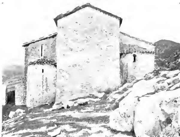
Fig. 127. Pedret, Absis (estat actual)
