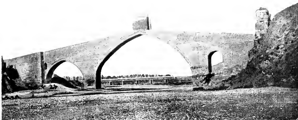
Fig. 112. Pont de Martorell. Albion pontorech monumental de Catalunya
