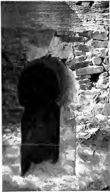
Fig. 436. Marquet. Arch de comunicació del absis principal ab el lateral N.
