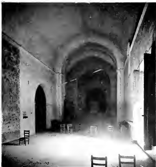
Fig. 353. Interior de Sant Pere de Tarrassa
