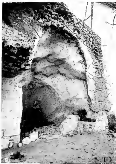
Fig. 110. Voltes para sostenir les grades del costat del mar del amfiteatre de Tarragona
