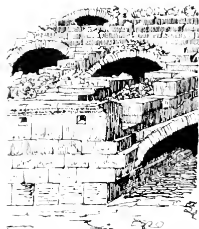
Fig. 116. Estructura de les grades del Circh de Tarragona y reconstrucció del podium segons l'Hernández Sanahuja.
