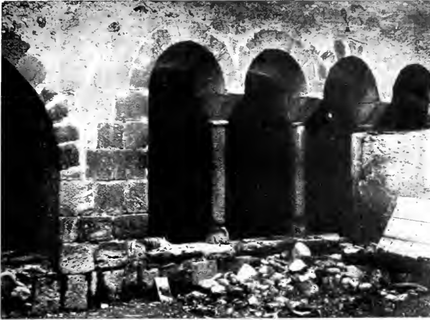
Fig. 292. — Claustre del monastir de Santa Maria de Cervià. (Fot. del Centre Excursionista.)
