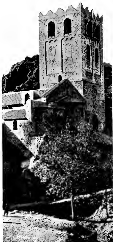
Fig. 40. — Absis y campanar de St. Martí del Canigó després de restaurats.
