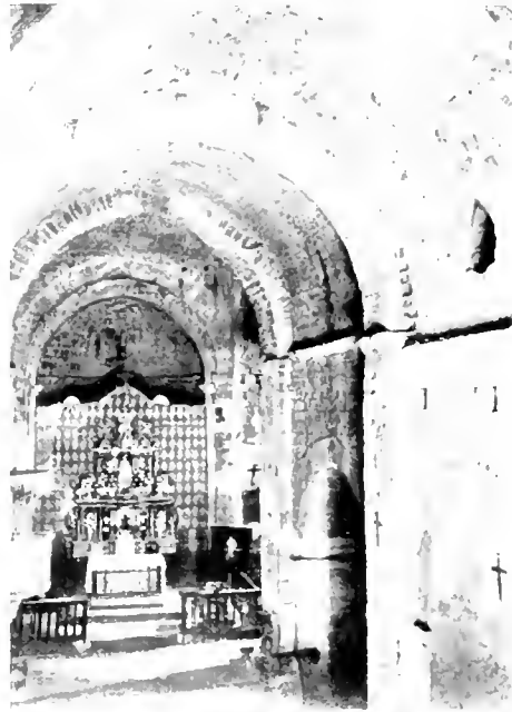
Fig. 408. — Voltes de Gualter ab les dues menes d'aparells.
