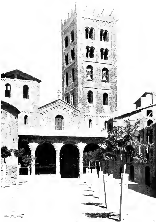
Fig. 410.— Campanar de Ripoll en la fatxada. (Restauració de Rogent.)
