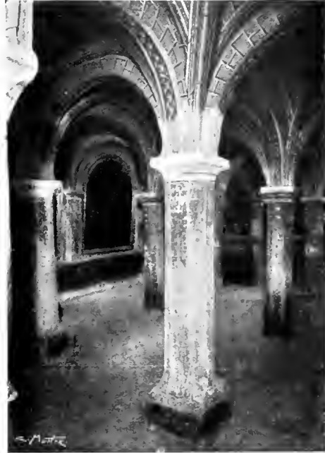
Fig. 116. — Cripta de la catedral de Roda. (Fots. de la Missió a la frontera d'Aragó.)
