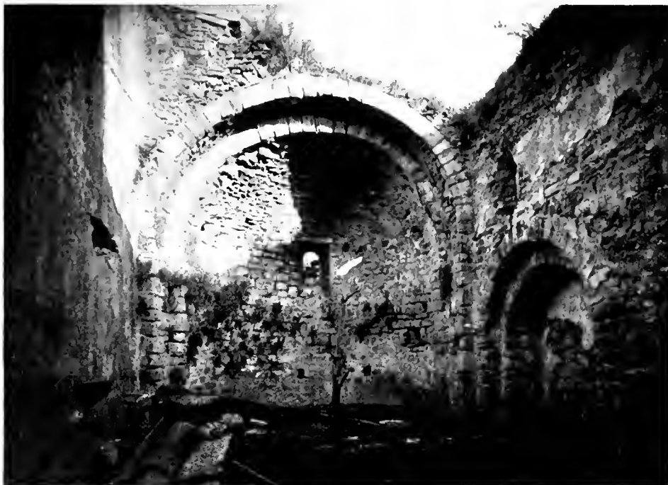
Fig. 409. — Aparell del absis de Sant Llorenç del Munt a les Guilleries. (Fot. Mas.)
