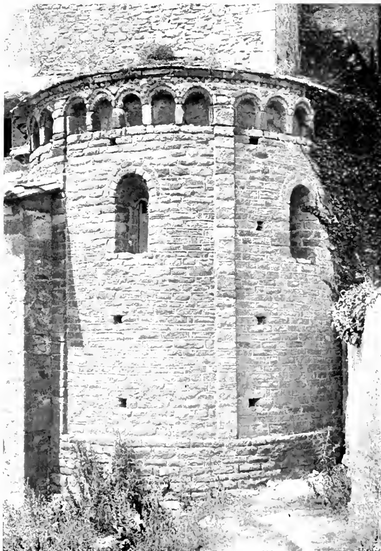
Fig. 397. — Vilalleons. Aparell del absis. (Fot. Mas.)
