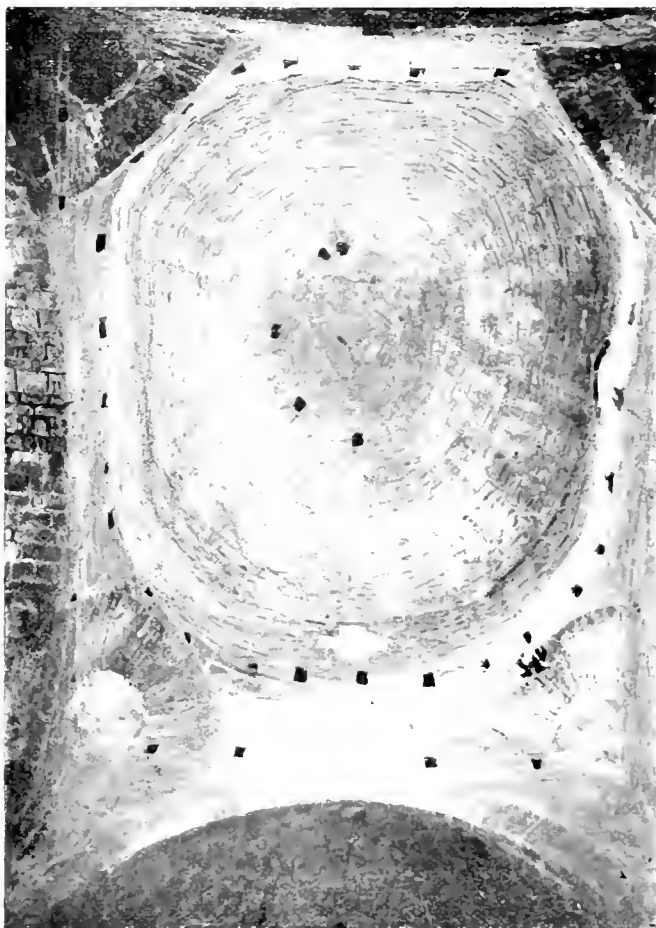
Fig. 427. Cúpula ab els forats del cindri de l'església de Gualter.
