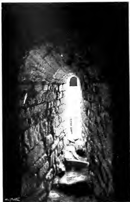
Fig. 422 — Finestra del campanar de Vich ab les senyals de cindri.
