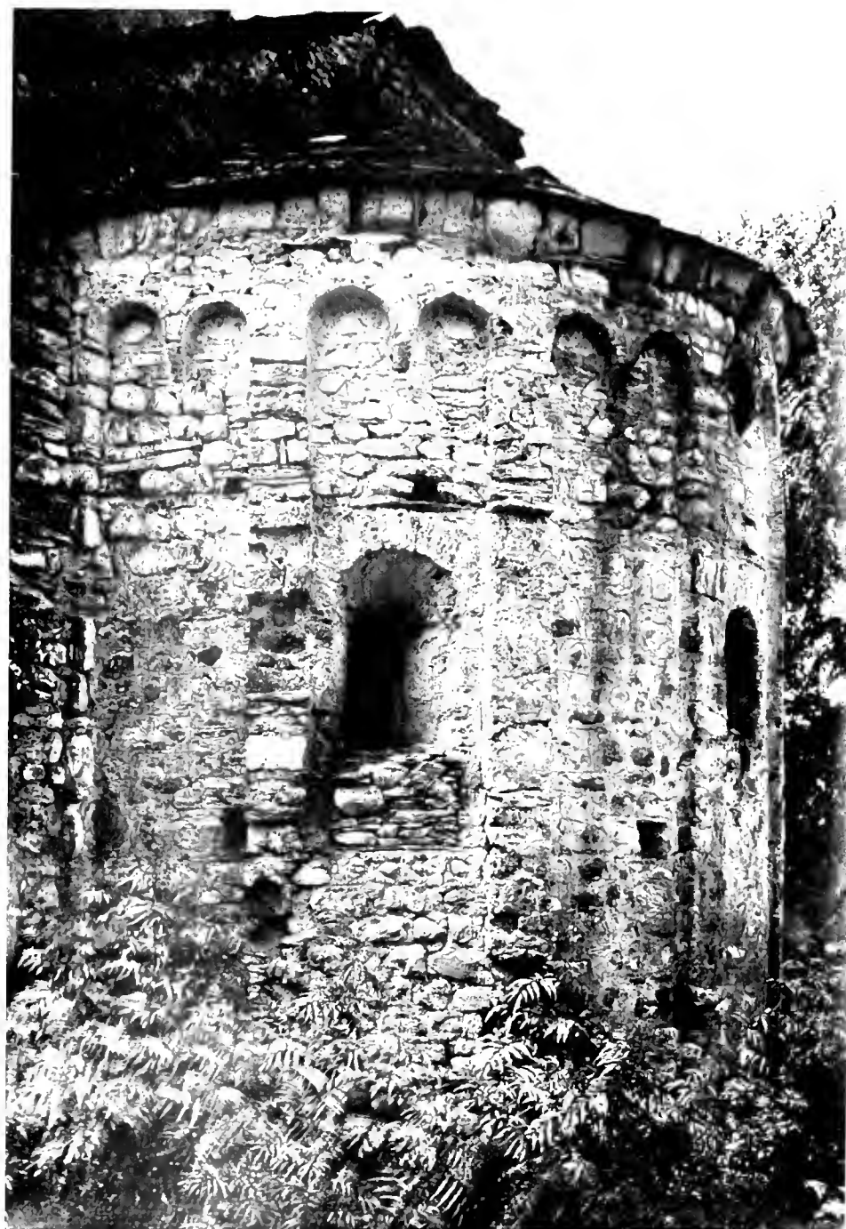
Fig. 393. — Obra de rebta del absis de Santa Maria d'Anou. (Fot. Mas.)
