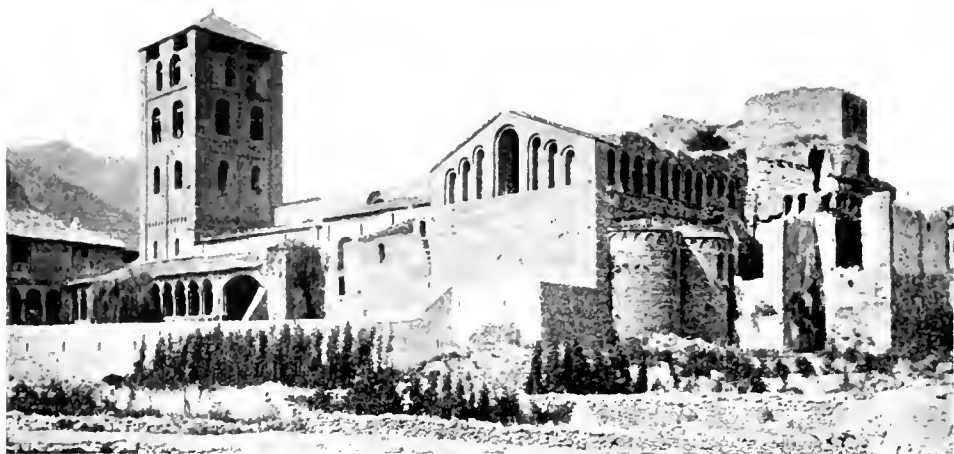
Fig. 67. — Basílica de Ripoll, al començament de la restauració. (Fot. Rogent.)
