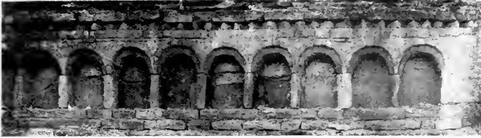
Fig. 1. — Església de Vilalleons (Plana de Vich). Finestres cegues de la cornisa de la nau.
