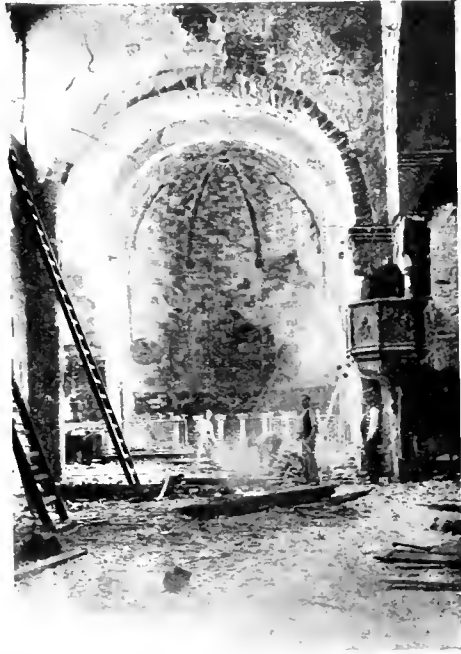
Fig. 36. — Creuer de Sant Pere de les Puellas, després del incendi de 1909.
