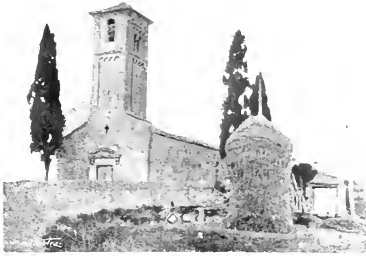
Fig. 256. — Església de Sant Jaume de Viladroher o dels Bastens.
