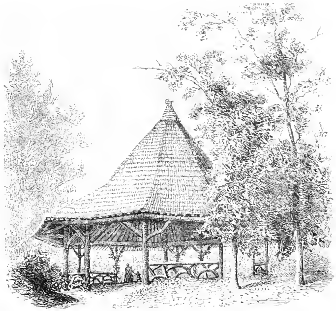
Fig. 249. — Abri de Cavaliers. (Foyer p. 185.)
