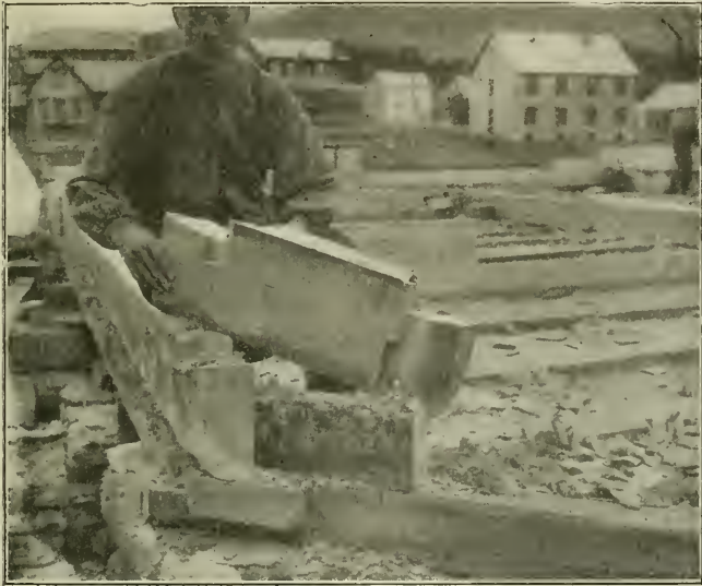
LA CONSTRUCTION D'UN CHALET NORVÉGIEN
