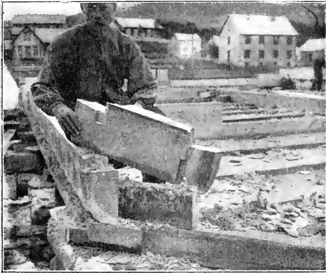
LA CONSTRUCTION D'UN CHALET NORVÉGIEN
