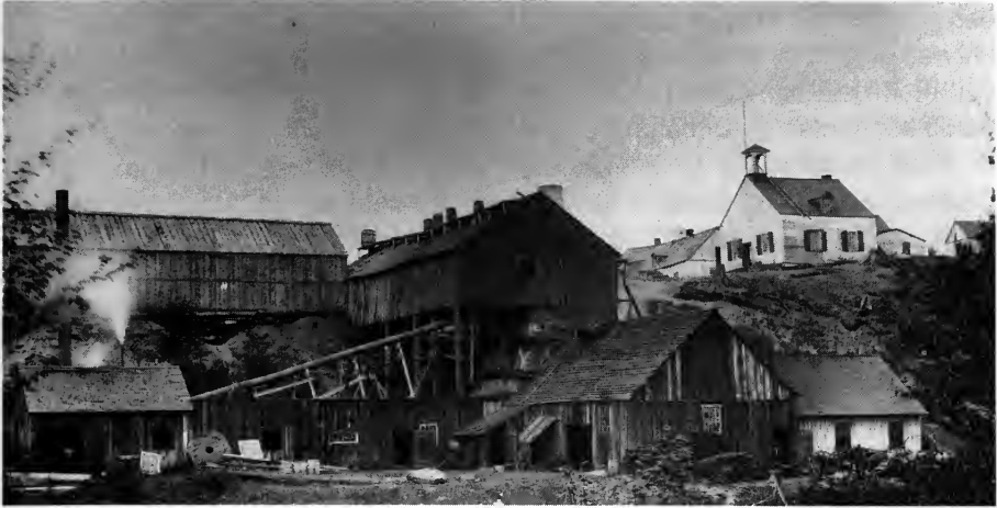
Les Forges L'Islet. En avant-plan, à gauche, la machine à vapeur ; à droite, le haut fourneau situé au pied du coteau pour en faciliter le chargement.
