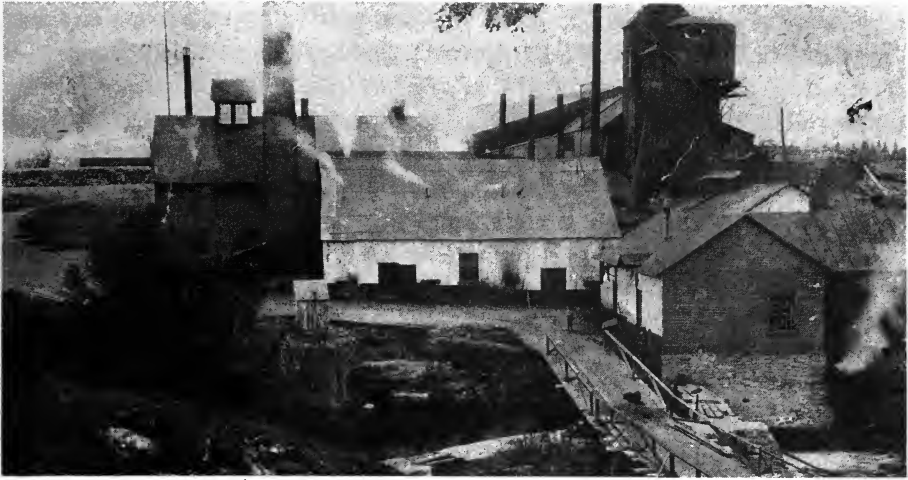
Forges Radnor et bâtiments connexes.
