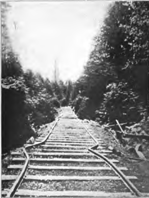
Fig. 49. — Raccourcissement de voie ferrée causé par le tremblement de terre de San-Francisco du 18 avril 1906.
