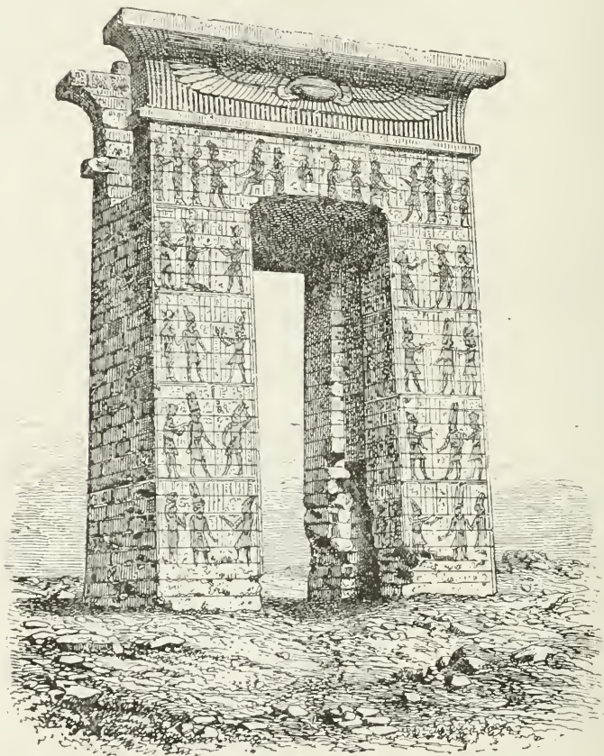
Fig. 99. — Pylône, à Karnak.
