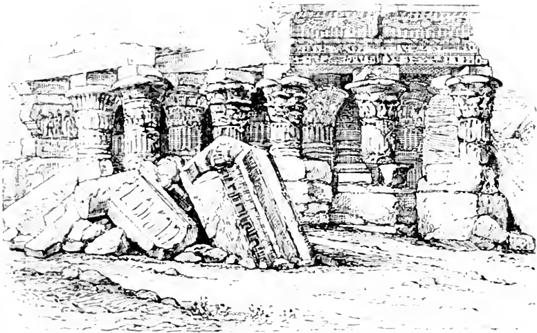
Fig. 104. — Vue des ruines du grand temple d'Ombos.
