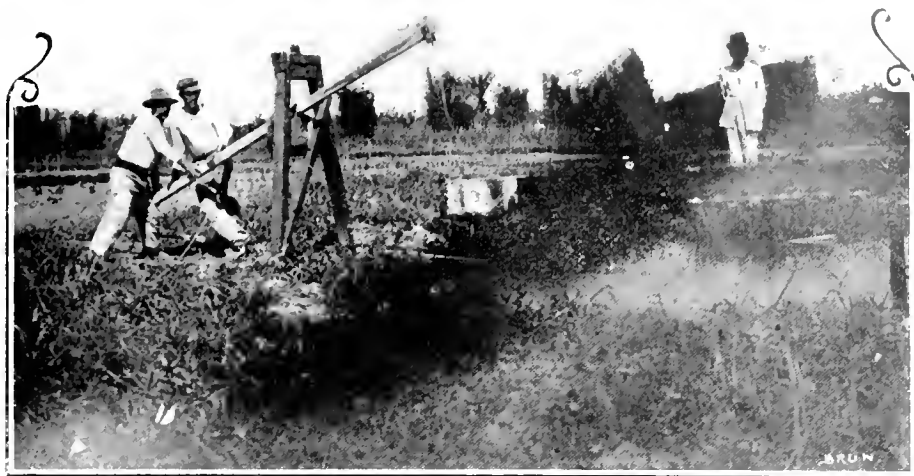
Calha holandesa para irrigação
