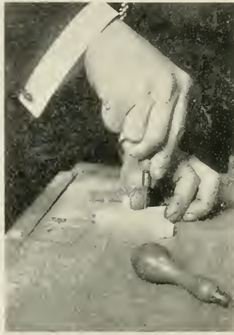
FIG. 31. USING BRADAWL.
