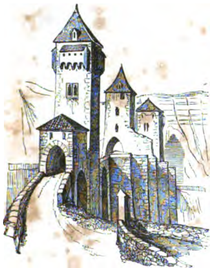
Fig. XV. Pont de Cahors.
