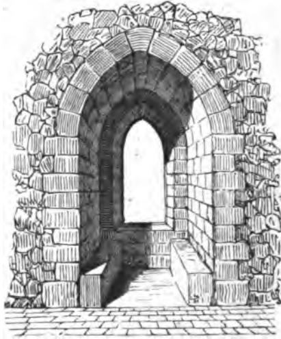
Fig. XCII. Fenêtre avec bancs en pierre.
