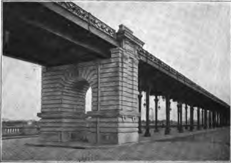
Fig. 31. — Culée de Passy. Pylône supérieur. Vue d'ensemble de l'ouvrage.
