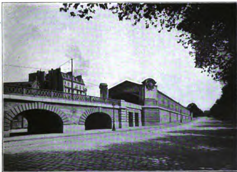
Fig. 42. — Station « Rue Corvisart ». Vue d'ensemble.
