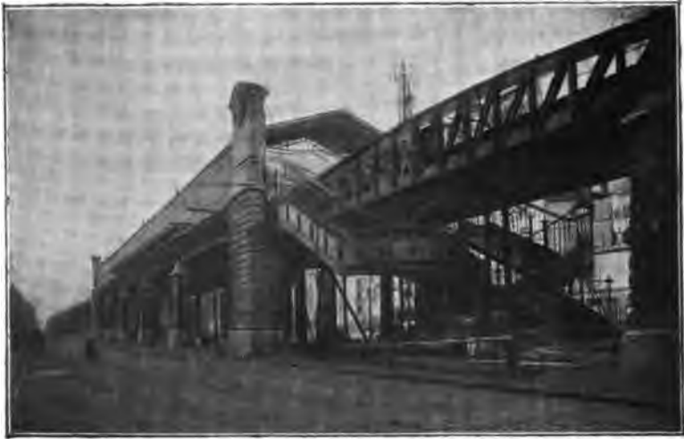
Fig. 13. — Accès à la station « Rue de Sèvres » en cours de construction.
