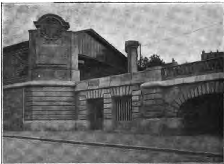
Fig. 18. — Vue des accès à la station « Rue Corvisart ».
