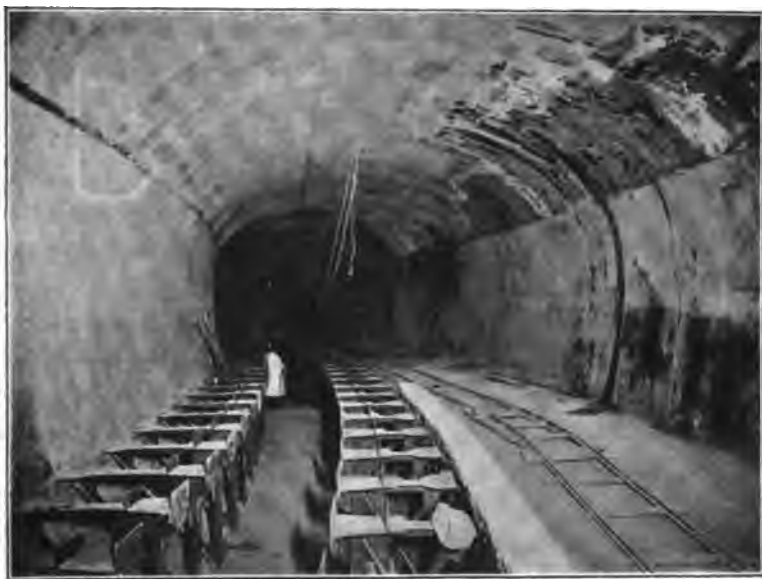
Fig. 48. — Couloir de visite de la boucle de la place d'Italie. Vue des chevalets avant la pose des voies.
