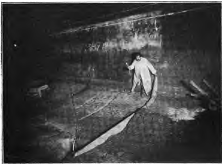
Fig. 75. — Préparation de drainages pour l'écoulement des eaux d'infiltrations.
