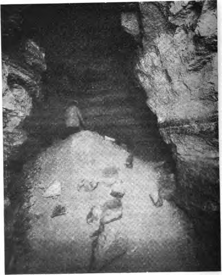
Fig. 4. — Fontis avec son cône d'éboulement.
