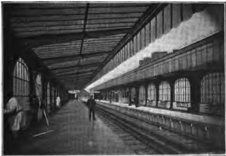
Fig. 19. — Type de couverture d'une station en viaduc de la ligne circulaire Nord.
