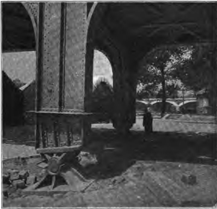
Fig. 62. — Appareil d'appui de l'un des piédroits du portique central.
