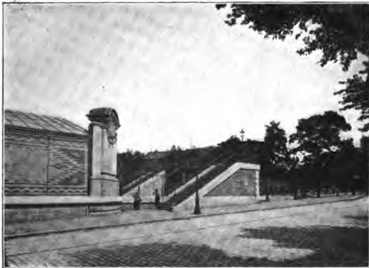
Fig. 43. — Passerelle du boulevard Auguste-Blanqui. Vue d'ensemble.
