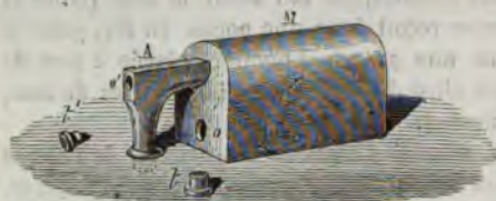
Fig. 528. — Moule contenant le minéral mélangé de charbon.
