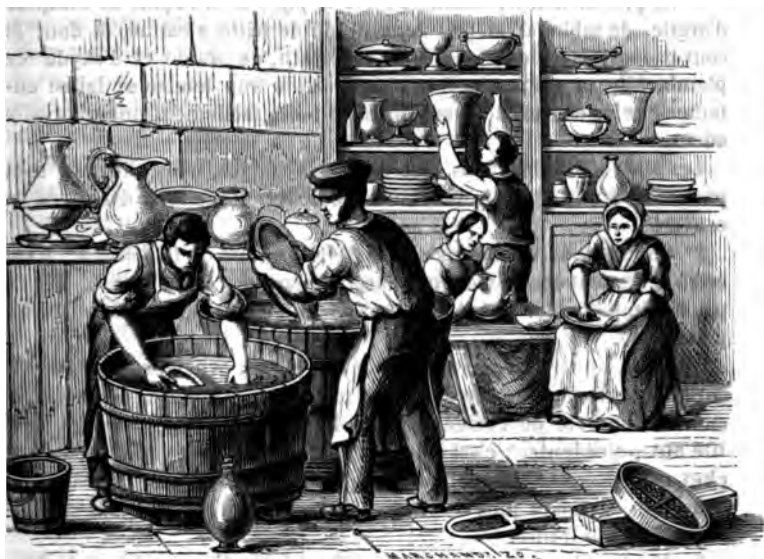
Fig. 587. — Vernissage de la faïence par immersion.
