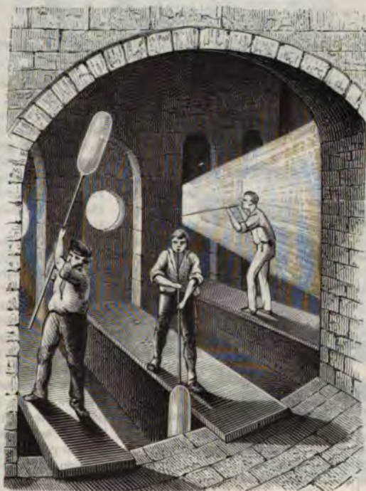
Fig. 602. — Intérieur d'un atelier où des ouvriers soufflent le verre.
