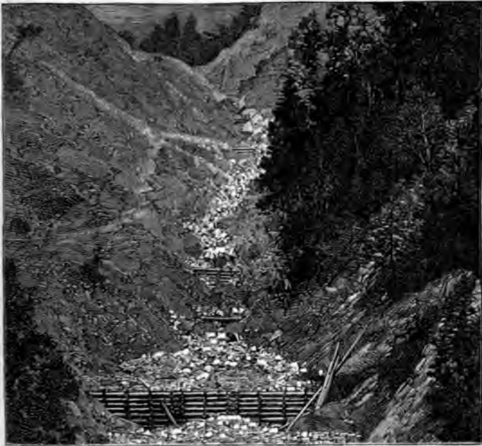
Fig. 64. — Torrent des Alpes, avec barrages pour briser la pente.
