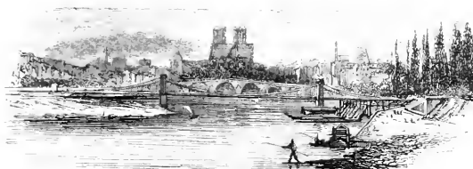
Passerelle de Constantin.
