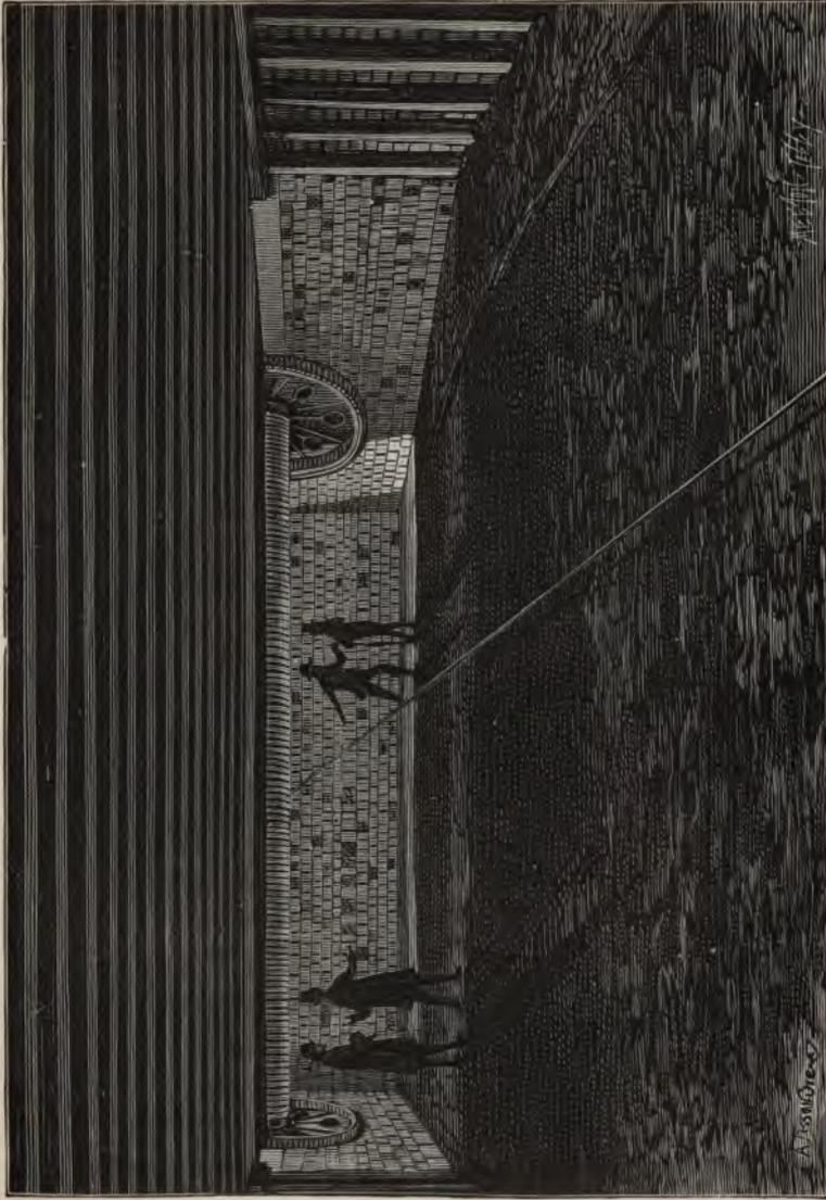
**Fig. 50. —** Le tunnel souterrain du câble du ballon captif. Vue prise dans sa plus grande largeur du côté du treuil.
