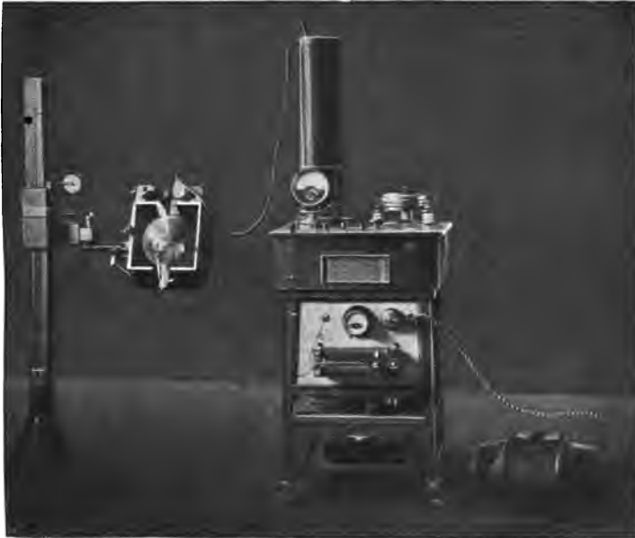
Abb. 23. Äußere Ansicht des Polyfrequenz-Diathermie- und Röntgenapparates.
