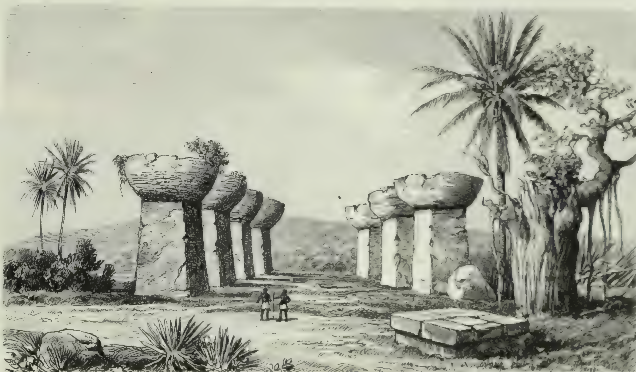
2. Alte Bauten auf Tinian. (Zu S. 65, 66, 72.)
