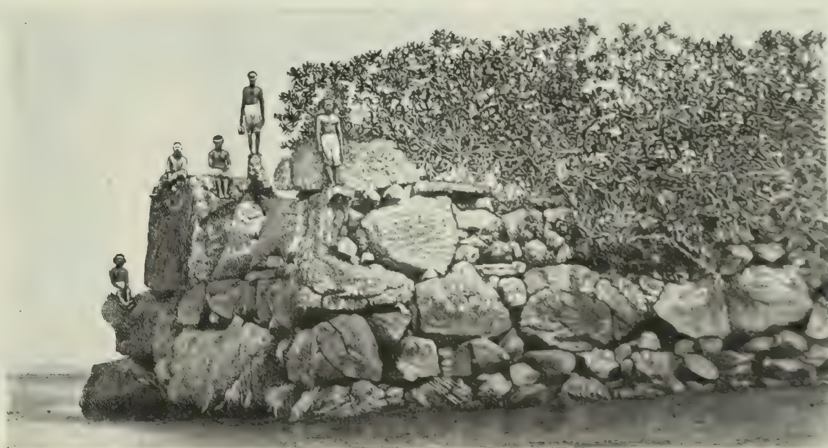
3. Alte Steinbauten auf Ponape. (Zu S. 65.)
