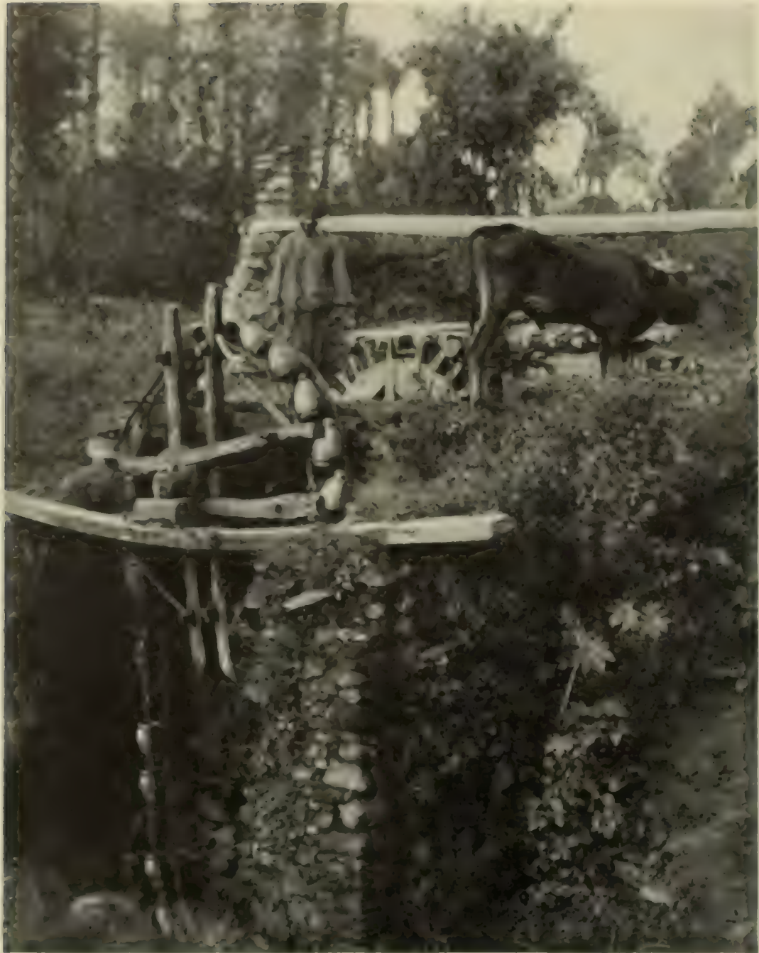
1. Eine ägyptische Sakije (Schöpfrad mit Göpelwerk). (Zu S. 102.)
