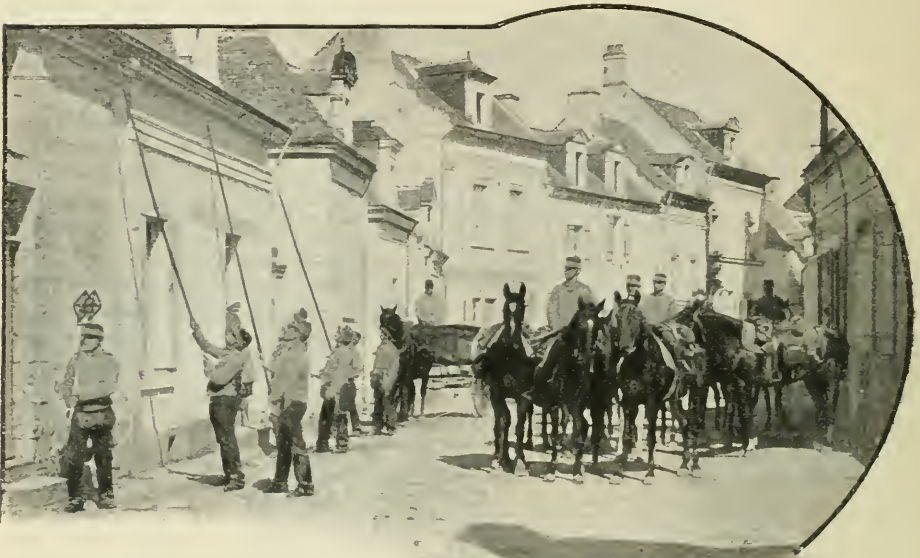
POSE D'UNE LIGNE TÉLÉGRAPHIQUE PAR LA CAVALERIE
