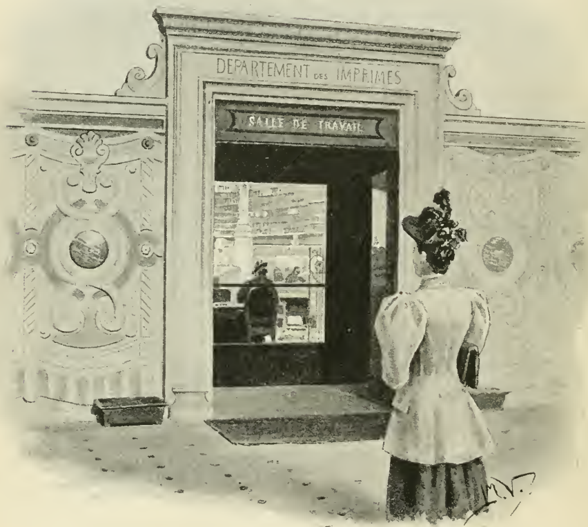
SALLE DE TRAVAIL VUE DU VESTIBULE
