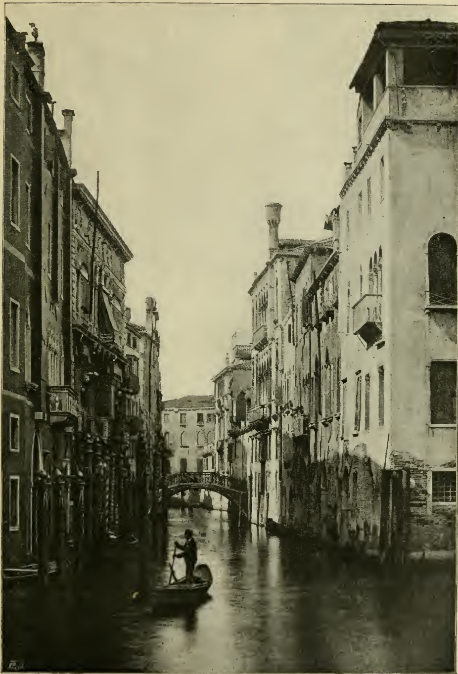
VUE DU CANAL SAN MARINA
