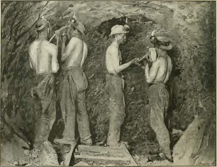
ATTAQUE D'UNE VOIE DE FOND (FRONT DE TAILLE)
