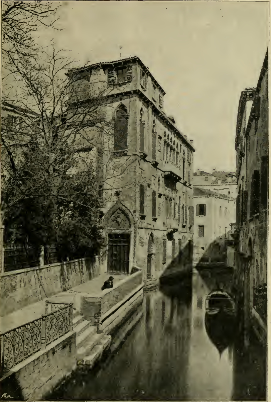
PALAIS SUR LES BORDS DU CANAL SAN MARINA
