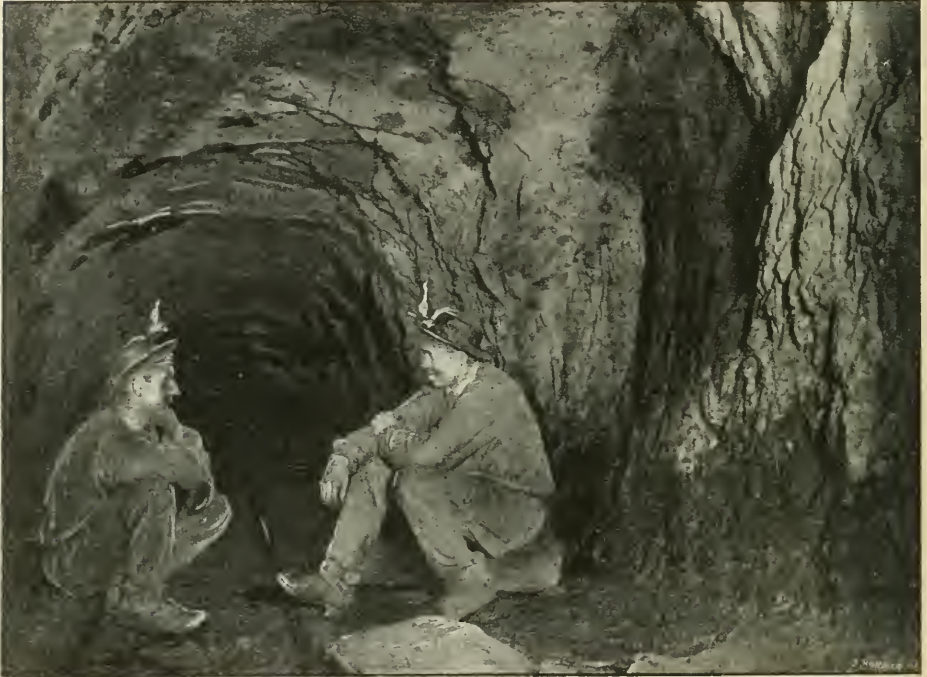
VUE D'UNE GALERIE DE ROULAGE
