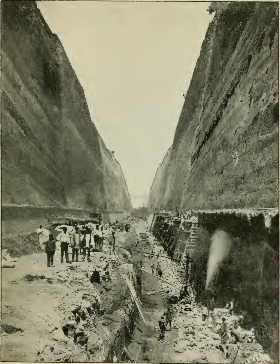
Construction à sec de la maçonnerie de revêtement de la paroi de la cuvette. — Vue prise en 1892.
