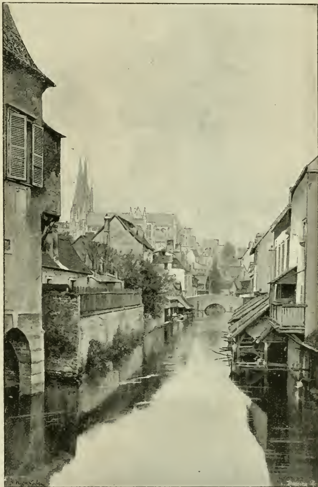
VUE PRISE DU PONT SAINT-PÈRE
