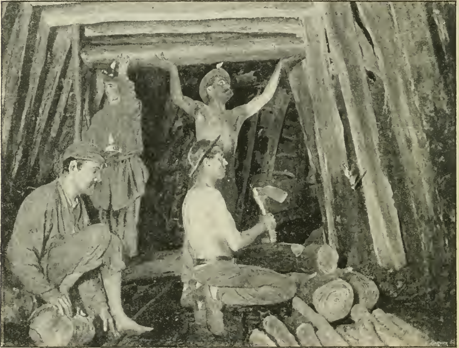
RÉFECTION D'UN BOISAGE
