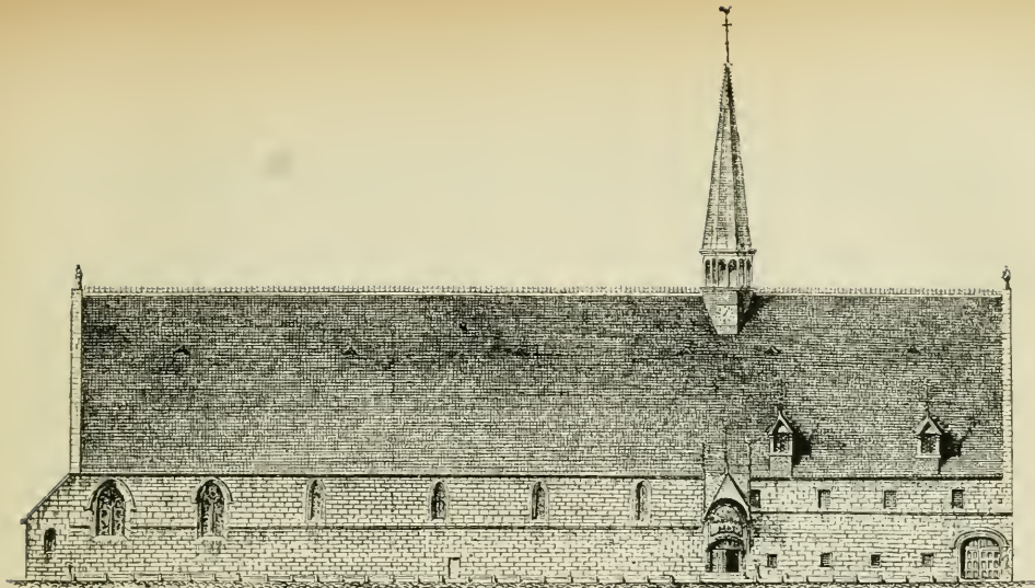
LA FAÇADE EXTÉRIEURE DE L'HÔPITAL SUR LA RUE
