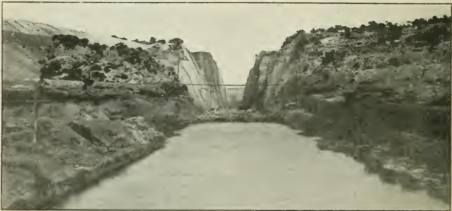
Barrage du côté du golfe d'Égine pour protéger l'excavation à sec de la partie centrale du fond de la tranchée.
