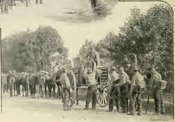
EQUIPEMENT DE CAVALIERS TÉLÉGRAPHISTES POUR CONSTRUIRE UNE LIGNE
