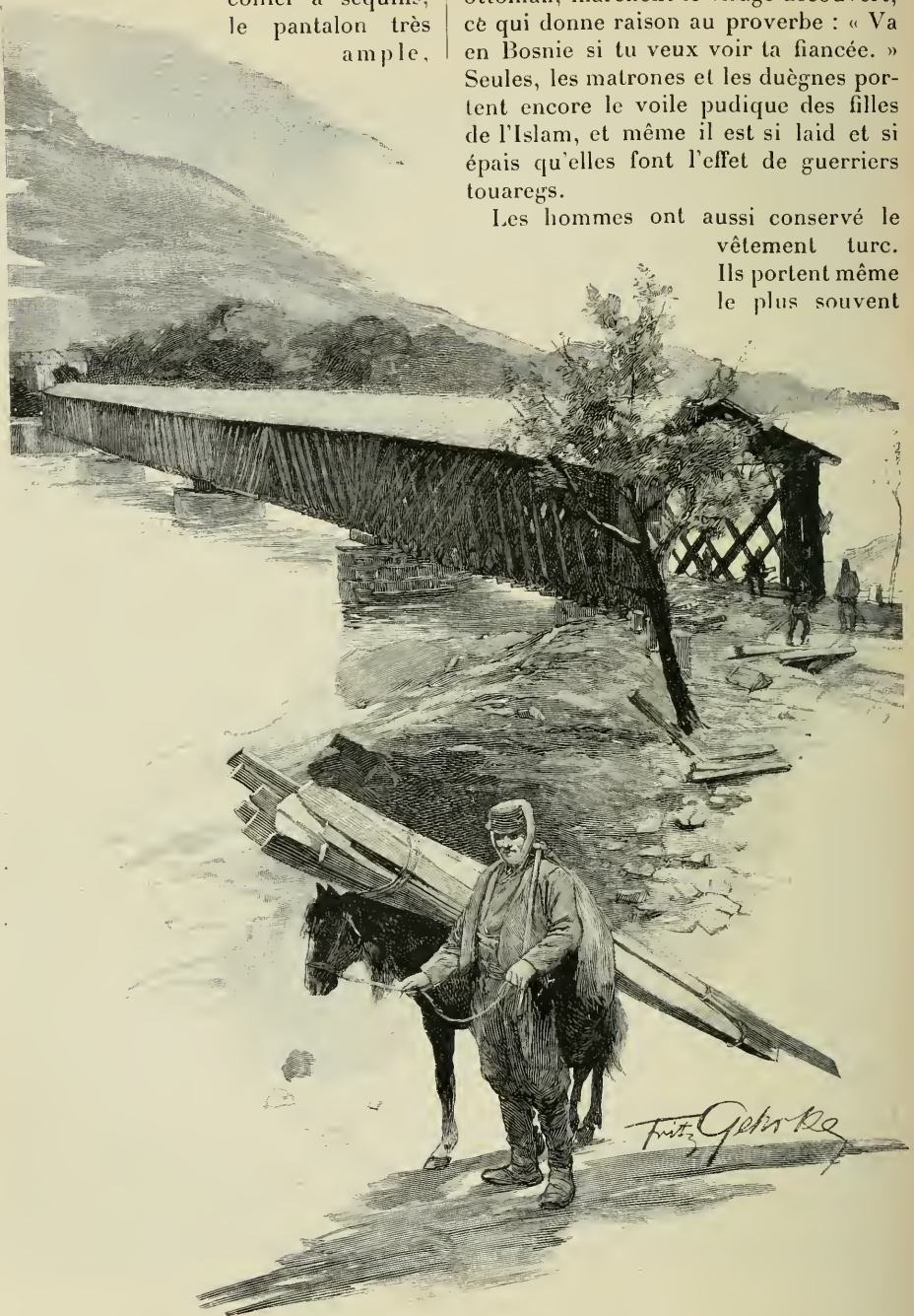
CONSTRUCTION DU PONT DE LA DRINA
