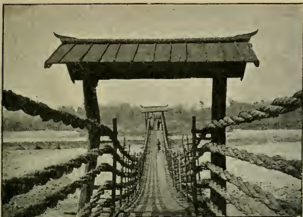
CHINE DE L'OUEST — UN PONT SUSPENDU
