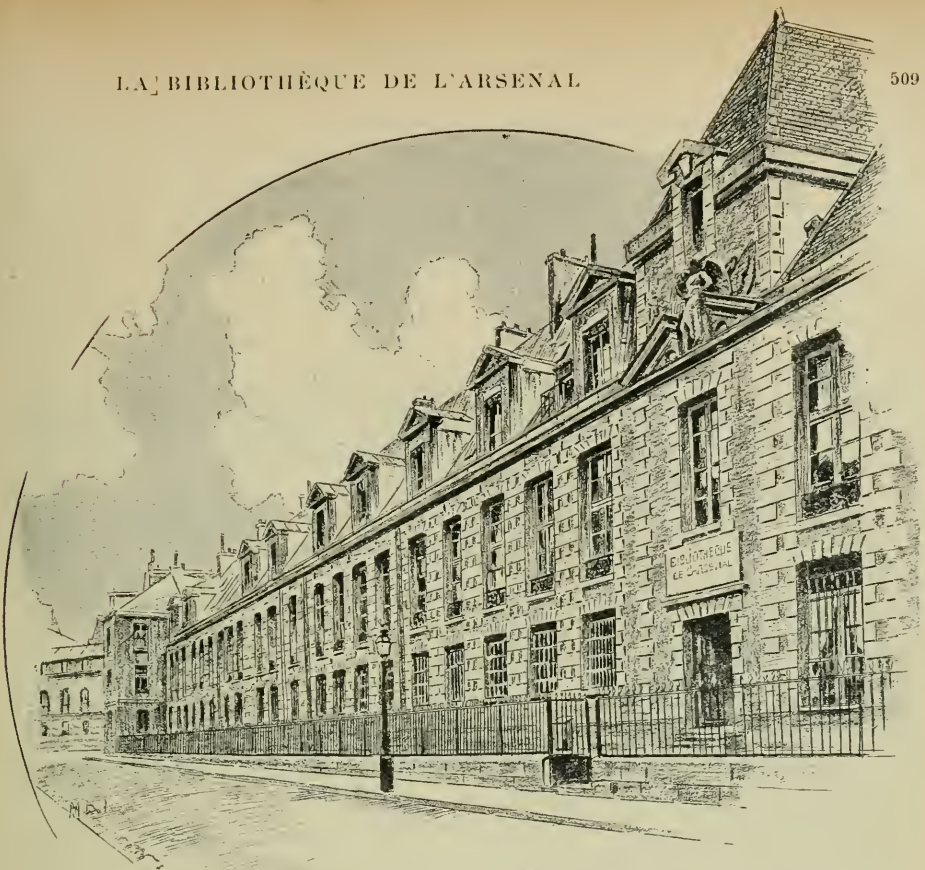
FAÇADE SUR LA RUE DE SULLY
