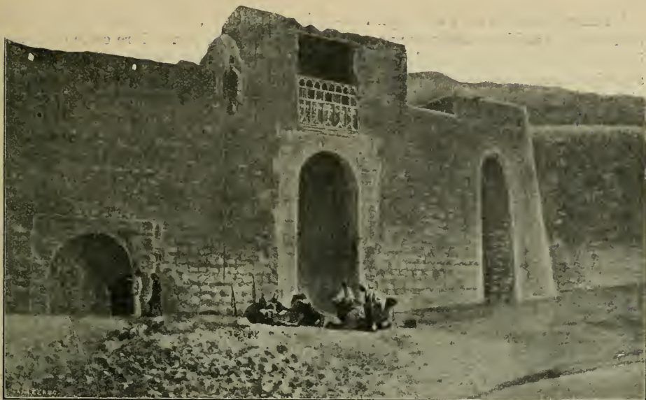
FAÇADE PRINCIPALE DU MONASTÈRE
