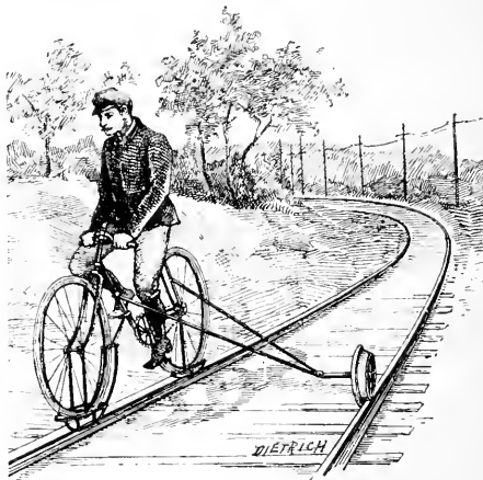
Fig. 6. — Bicyclette disposée pour courir sur les rails d'une voie de chemin de fer.
