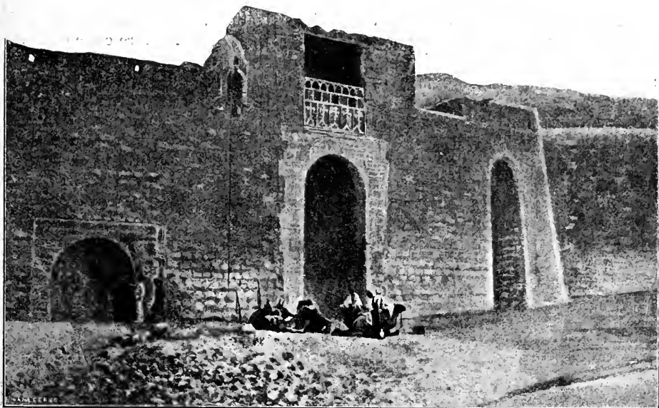
FAÇADE PRINCIPALE DU MONASTÈRE
