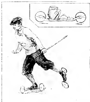
Fig. 8. — Patins portant deux roues garnies de caoutchoucs creux et permettant de courir sur les routes ordinaires.
