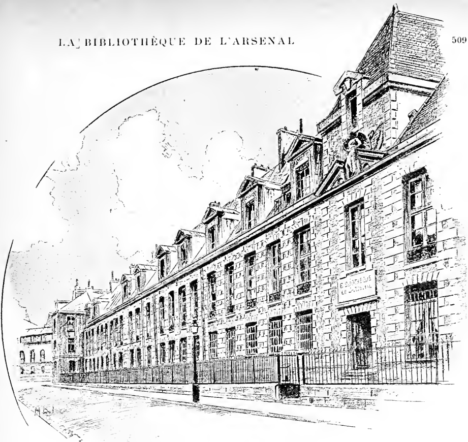
FAÇADE SUR LA RUE DE SULLY
