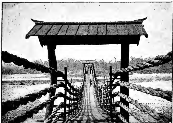
CHINE DE L'OUEST — UN PONT SUSPENDU
