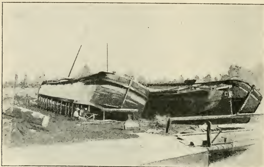
CHANTIERS DE CONSTRUCTION
