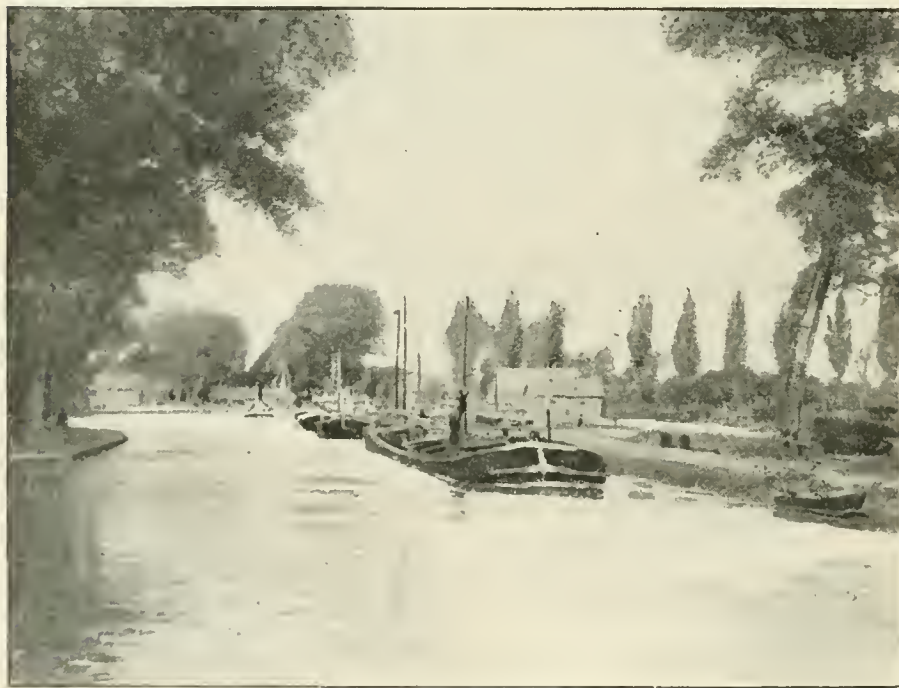
LES ABORDS DU BASSIN ROND
