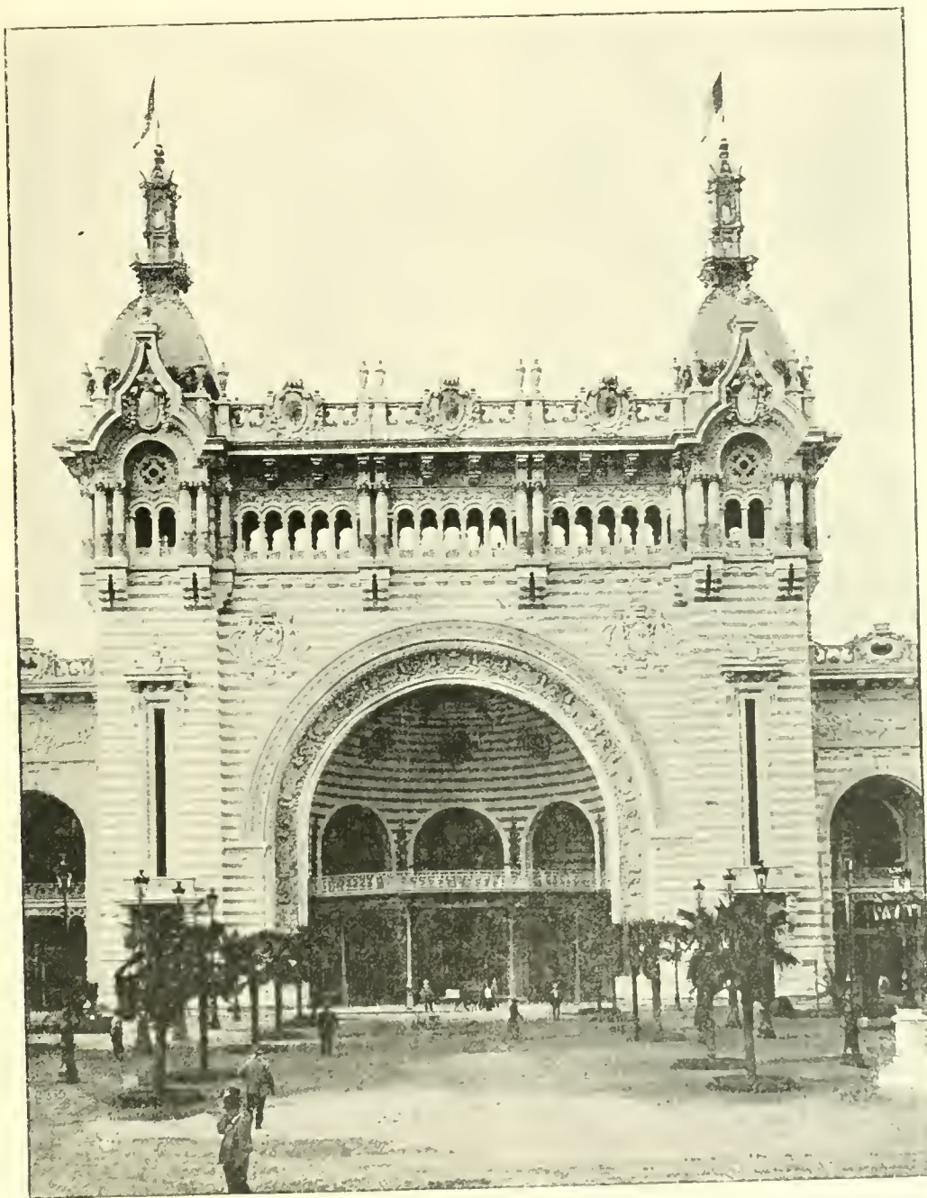
PORCHE D'ENTRÉE DE PALAIS DU GÉNIE CIVIL
