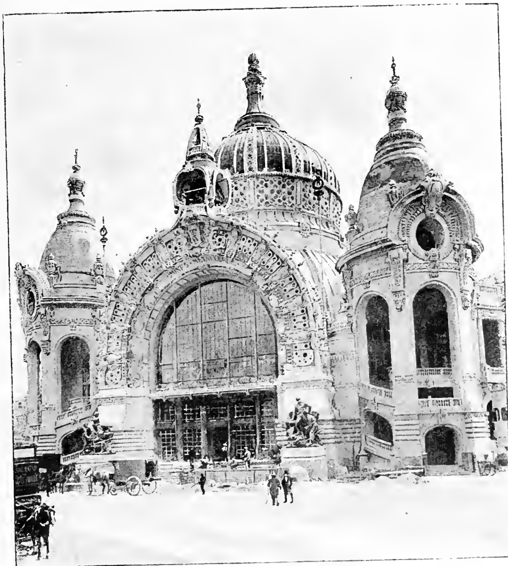
PORCHE PRINCIPAL DU PALAIS DES MINES ET DE LA MÉTALLURGIE
