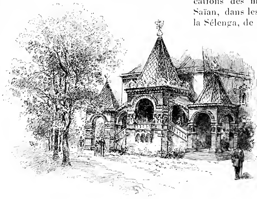
PAVILLON DES APANAGES IMPÉRIAUX
