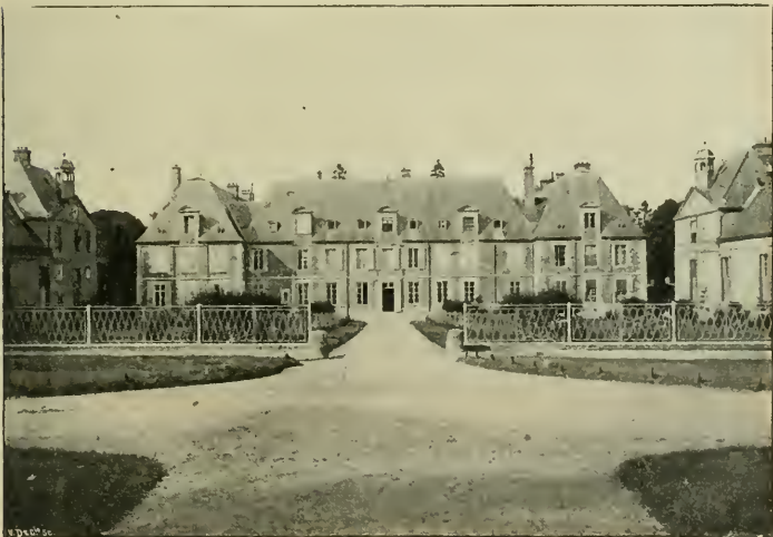
LE CHATEAU — FAÇADE PRINCIPALE
