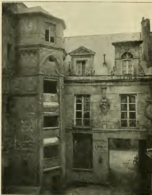
COUR CHARLEMAGNE, RUE SAINT-ANTOINE
