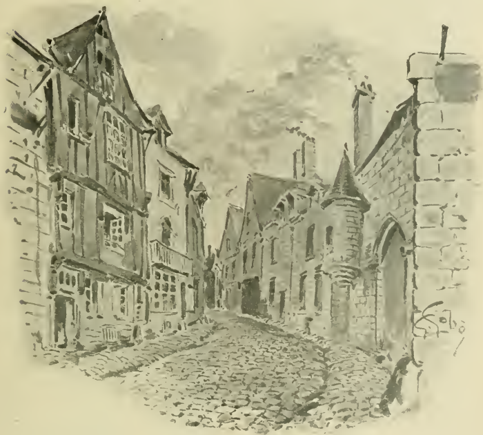
VIEILLES MAISONS DU QUARTIER SAINT-MAURICE
