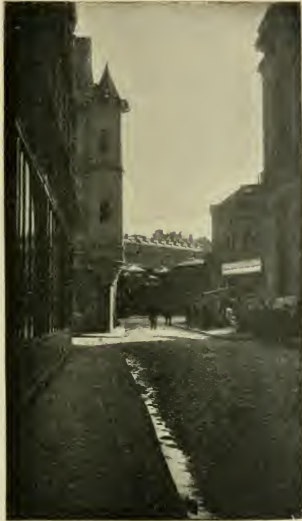
MAISON A TOURELLE, RUE HAUTEFEUILLE
