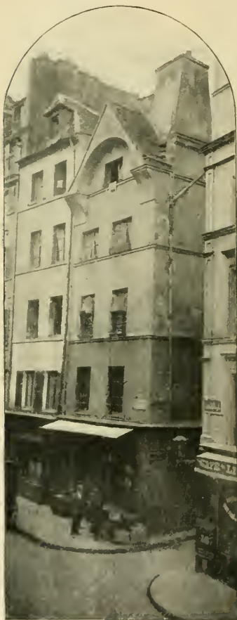
MAISON A PIGNON RUE FRANÇOIS-MIRON
