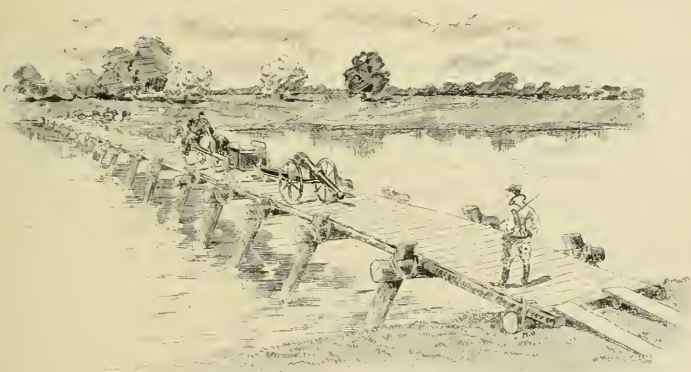
PONT DE CHEVALETS
