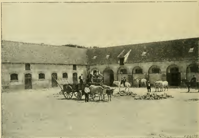
PREMIÈRE COUR DE LA FERME
