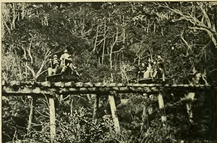
EN NOUVELLE-CALÉDONIE — CHEMIN DE FER D'EXPLOITATION FORESTIÈRE
