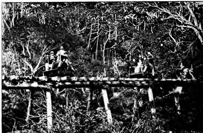
EN NOUVELLE-CALÉDONIE — CHEMIN DE FER D'EXPLOITATION FORESTIÈRE
