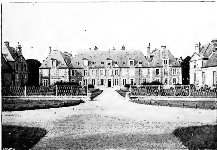
LE CHATEAU — FAÇADE PRINCIPALE
