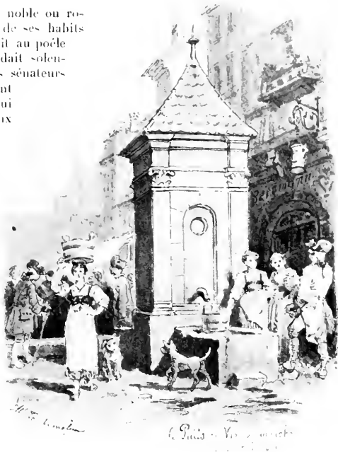
VIEUX PUIS DIT FISCHBRUNNEN
