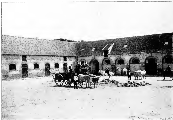
PREMIÈRE COUR DE LA FERME
