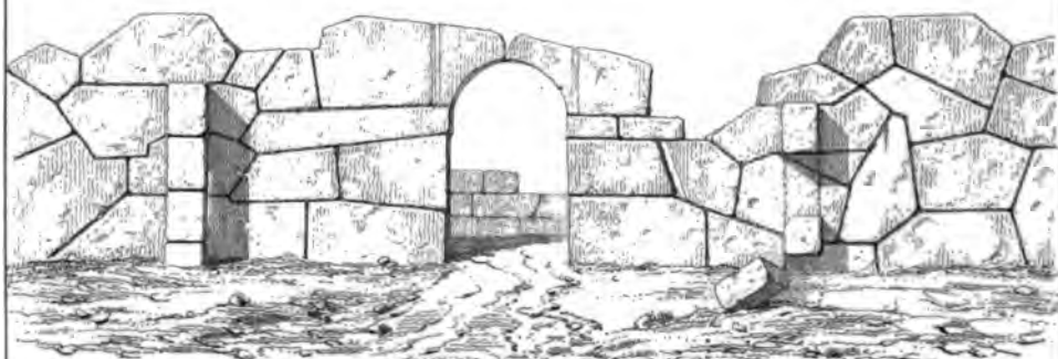
2. Portique de Construction Cyclopéenne À KOMBOTI
