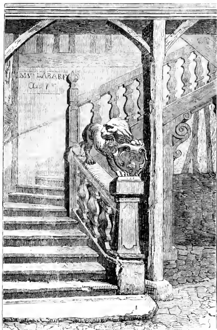
Escalier de la maison des orfèvres de Rouen (état actuel). — L'écusson que tient le lion avec sa patte renferme les armoiries des orfèvres de Rouen.
