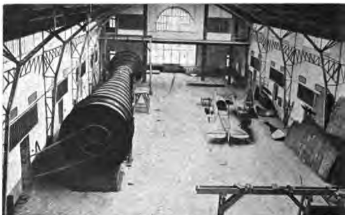
Fig. 80. — La salle du ventilateur à l'Institut aérodynamique de Saint-Cyr. de 2 mètres et une vitesse de 32 mètres par seconde, soit
