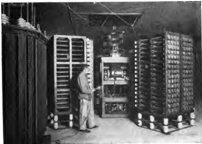
Fig. 199. — La salle de l'éclateur à la Tour.
