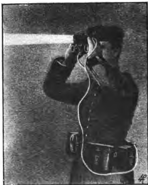
Fig. 15. — Appareils portatifs allemands de télégraphie optique.
