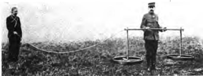
Fig. 146. — Recherche des obus sur le terrain au moyen de la balance du 1 er Gutton.
