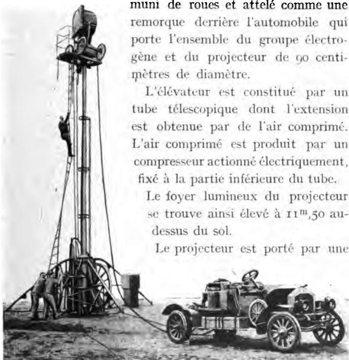
Fig. 7. — Projecteur monté sur un mât extensible.
