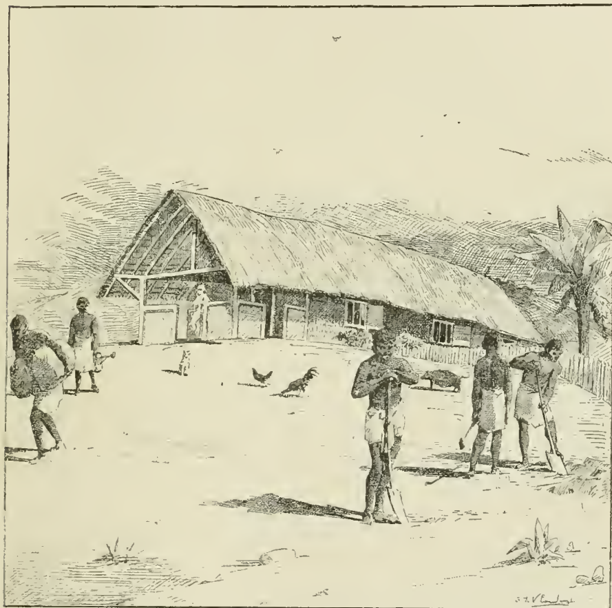
PREMIÈRE MAISON CONSTRUITE A ISSANGHILA PAR LE LIEUTENANT JANSSEN.
