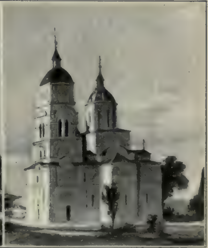
Fig. 33. — Lazaritza avant la dernière reconstruction. (Phot. Kanitz).
