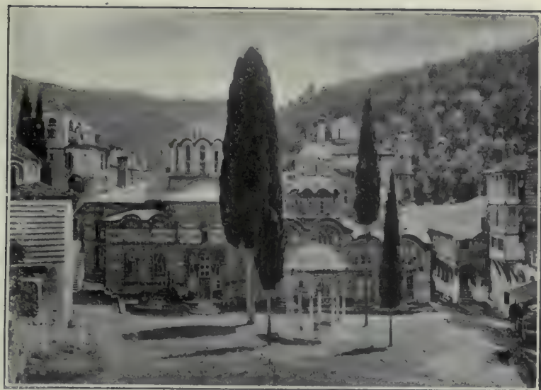
Fig. 9. — Cour et façade ouest de l'église de Hilandar, au Mont-Athos.
