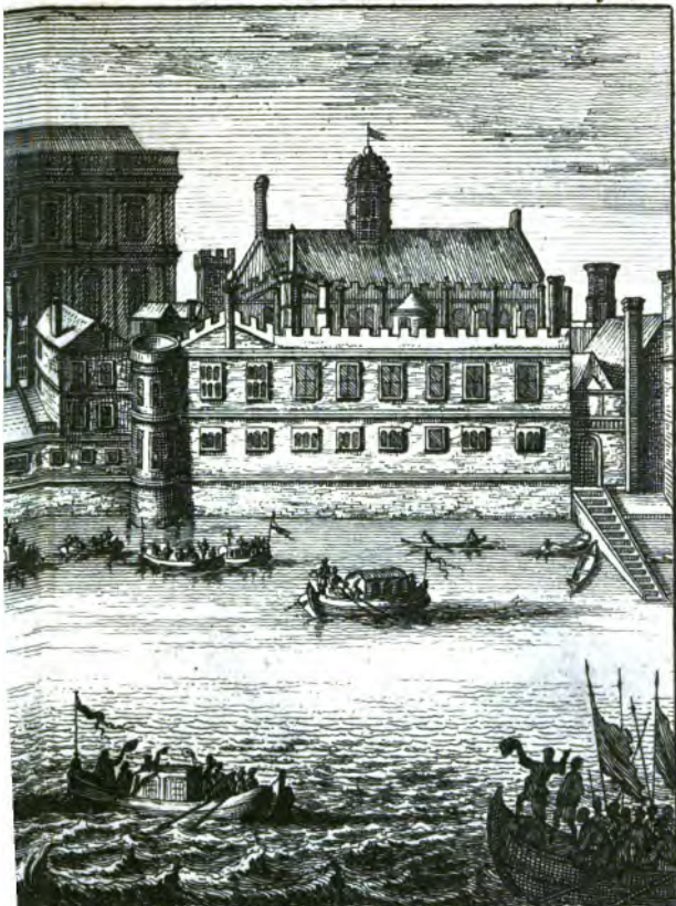
E-HALL, qui fait face TAMISE.
