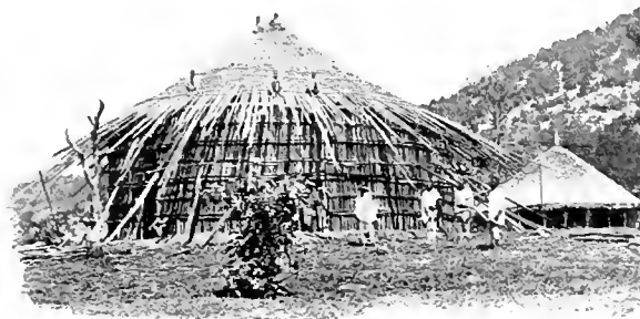
UNE CASE EN CONSTRUCTION AU CHOU
